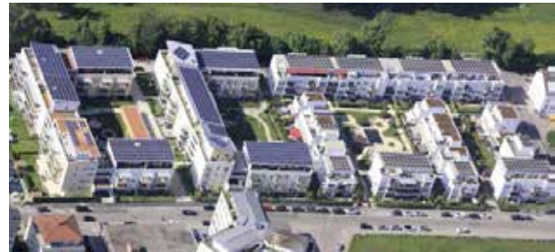
شكل رقم ٦- يوضح استخدام وحدات الطاقة الشمسية بأسطح مباني سكنية بألمانيا لتوفير الطاقة اللازمة لتشغيل المباني، ١٦ (source : www.bine.info ) (Ludmilla housing estate- energy-plus standards)
