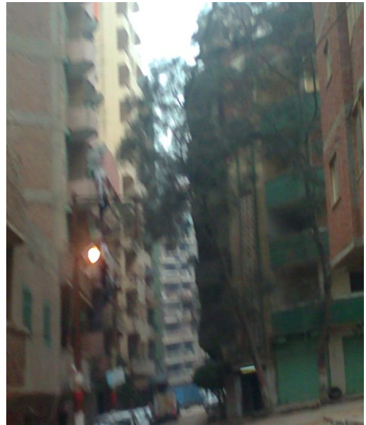
شكل (3) يوضح ارتفاع المباني و ضيق الشوارع بما لا يسمح بتوفير الراحة و الخصوصية لمستعملي شرفات هذه المباني.
