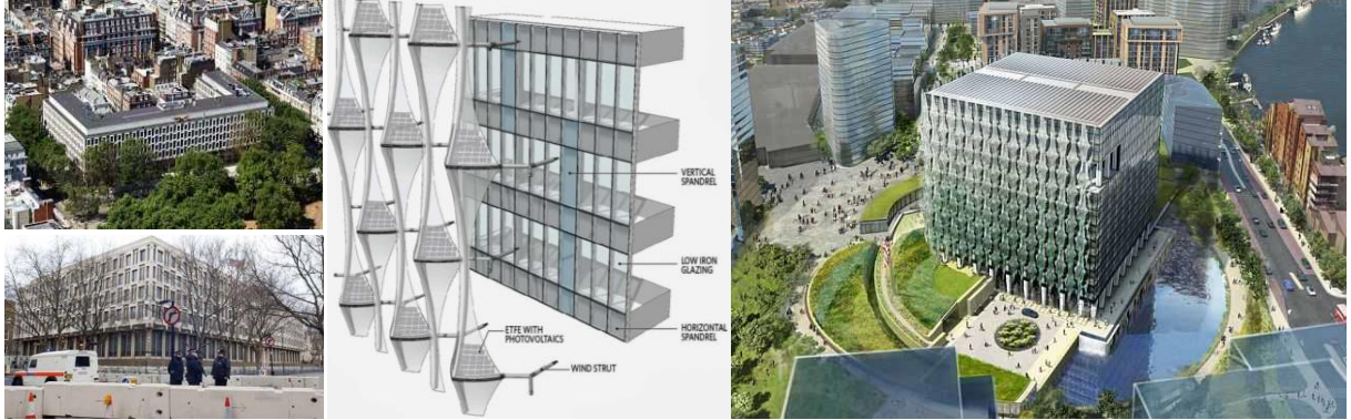
شكل ٢٣ يوضح إعادة تصميم مبنى السفارة الأمريكية- لندن، أسس تصميم ومفردات معمارية دفاعية برؤية حديثة ومستدامة [54] .
