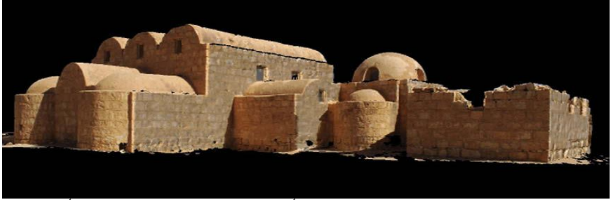
شكل رقم (٦): نموذج قصر العمرا الافتراضي ثلاثي الأبعاد وقد جمع بين مزايا كل من المسح بأشعة الليزر والتصوير المساحي الرقمي.
