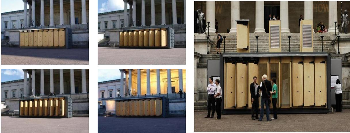
شكل رقم (١٢): نموذج الأغلفة الديناميكية بكلية بارثليت للعمارة بلندن والذي اعتمد على القوة الهيدروليكية التي يولدها شمع البارافين المجهز في خزانات خاصة أثناء تمدده بالحرارة لتفتح وتغلق الستائر تلقائياً بفعل الحرارة الخارجية.
