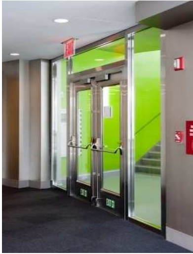
شكل (١-٣) باب مخرج هروب مع استخدام الزجاج المقاوم للحريق لمدة ٩٠ دقيقة ١ .
