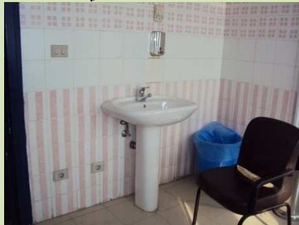
شكل (٧-١٩) حوض غسيل الأيدي بغرفة الكشف وغير ملحوم جيدا بالحائط.
