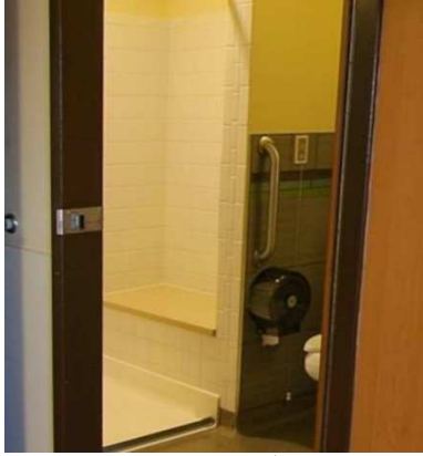
شكل (٥٨-٦) حمام الغرفة موضح به استخدام مقابض الارتكاز للمرضي.
