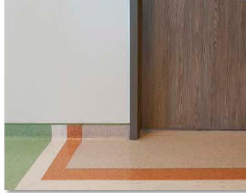
شكل (١٢-٥) يوضح اتصال الوزرات بالأرضيات والحوائط باستخدام الفينيل. ٤
