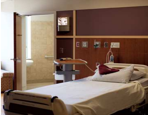
شكل (٦٠-٦) غرفة المريض موضحا بها bed head unit.
