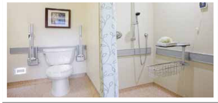
شكل رقم (٤-١٦) يوضح تصميم للقضبان الداعمة في حمام المريض ما بين قضيب رأسي أو مائل أو أفقي مع رأسي أو علي جانبي المراوض.
