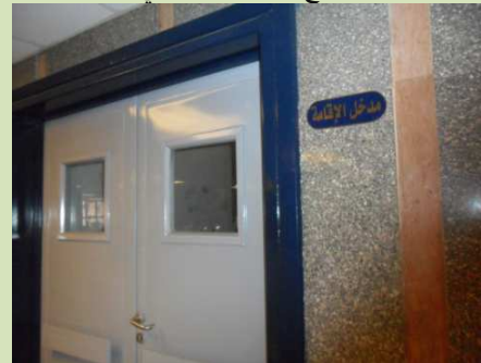
شكل (٧-٣٢) باب مدخل وحدة الإقامة مصنوع من الخشب وبه زجاج غير مقاوم للحرارة.
