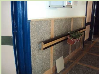
شكل (٧-٢٣) توضح استخدام القضبان الداعمة بالممرات مع توفير مسافة بينها وبين الحائط للتطهير.
