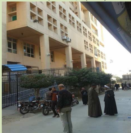
شكل (٧-٣٠) توضح تشطيبات الجدران الخارجية
