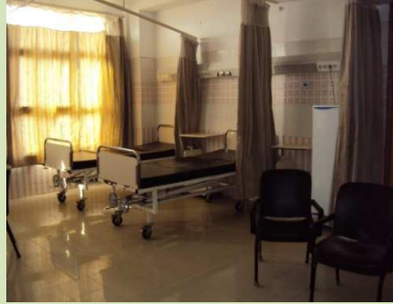
شكل (٧-٦) عنبر المرضى، تشطيب سيراميك بالأرضيات وجزء من الحوائط، وباقي ارتفاع الحوائط والسقف دهان بلاستيك.
