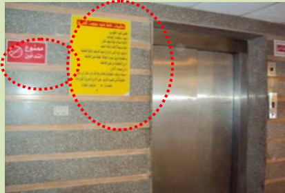
شكل (٧-٨١) استخدام العلامات الإرشادية ولوحة تعليمات عند بطارية الحركة الرأسية في حالة حدوث حريق.
