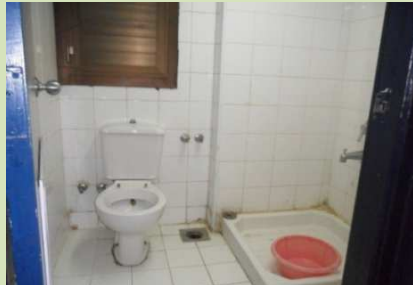
شكل (٧-٢٢) يوضح التنشيطات المستخدمة بحمامات الغرف، حيث يوجد فواصل غير ملحومة جيدا، واتصال الحوائط بالأرضيات غير دائرية، وأيضا تلاقي الحوائط مع بعضها دائري، وبالتالي تراكم الأوساخ وزيادة الضرر.
