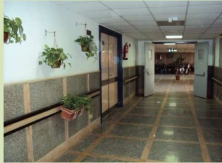
شكل (٧-٦) الممر أمام العنبر السابق وتشطيب الأرضيات وجزء من الحائط رخام، والسقف استخدام الأسقف المعلقة ( بلاطات الجيبسوم بورد) حيث تتميز بخفة الوزن وسهولة التركيب والصيانة وأيضا تتميز بمقاومتها العالية لنمو للبكتريا، وسهولة التنظيف ومقاومتها للرطوبة. يتميز السيراميك والرخام بسهولة تنظيفه ومقاومته للكيمويات ولكن الفواصل بينهم هي التي تعمل علي تراكم البكتريا والفطريات. يمتاز السيراميك والرخام بقوة التحمل وسهولة الصيانة والتنظيف ومقاومته للكيمويات، ويمتاز بالرطوبة المنخفضة لامتناعه البطئ للحرارة. أيضا أركان اتصال السورزات بالأرضيات غير دائري وغير مانع لنمو البكتريا.
