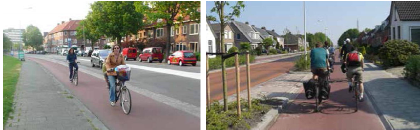
شكل (٤-١٧) توضح الصورة اليميني مسار الدراجات المنفصل بينما توضح الصورة اليسرى مسار الدراجات الملاصق لمسار السيارات
