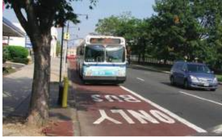
شكل (١٢-٢) تخصيص حارة مخصصة للحافلات بطريق (Fordham Road – Bronx) المصدر: http://nyc.streetsblog.org/2012 (April 2017)
