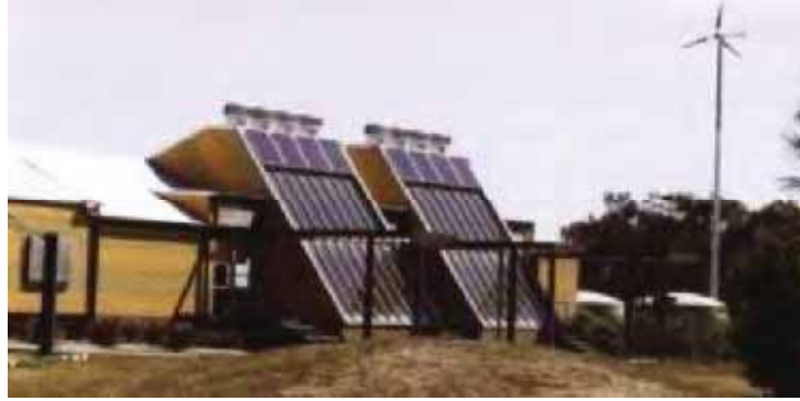
شكل ( ١ - ٣ - ٣٥ ) الواجهة الأمامية في مدرسة سانت ليونارد، مركز الاستدامة. المداخن الشمسية توفر الهواء الساخن وحمل التهوية في فصل الشتاء عبر في فصل الصيف (١)
