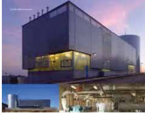
شكل (٣-١-٢) المحطة المركزية هي جوهر من الطاقة الحرم الجامعي استراتيجية (١)
