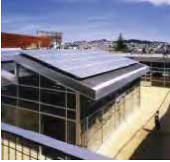
شكل ( ١ - ٣ - ٤ ) سقف الشمسية (٢) panelsat مدرسة ثانوية Lick Wilmerding
