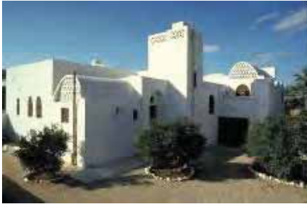
شكل (١-١-٤) الخامات والألوان المحلية المستخدمة فى المباني (١)
