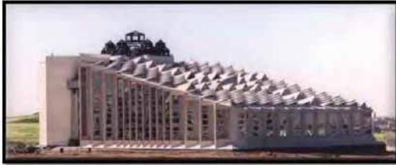
شكل (٣٤-٢-٤) كاسرات الشمس الافقية في الواجهة الجنوبية والاسلحة الرأسية في الواجهات الشرقية والغربية (٢)
