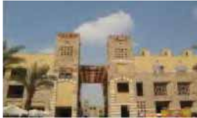
شكل (١٣-١-٤) ملاقف الهواء (wind catchers) التى تعنو الانفاق التى تربط بين الساحات والافنية الداخلية (٤)
