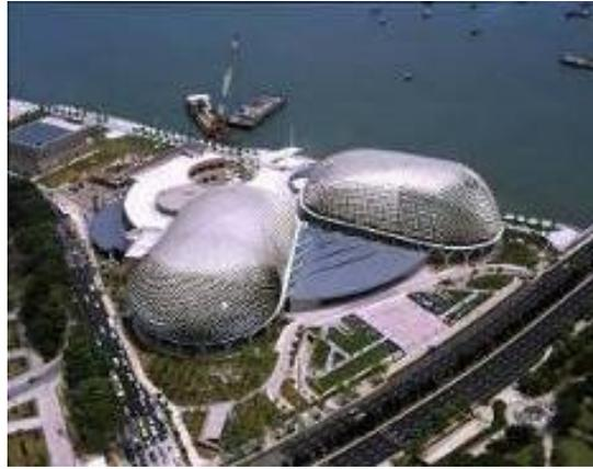
الشكل رقم (٢-٣-١٤) يوضح شبكة الأصداف المُقَوَّسَة grid shell المكون الرئيسي للغلاف الخارجي للمركز
