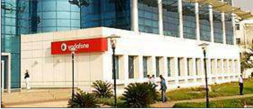
شكل (١٠٠-٢) استخدام بياض الحجر الصناعي في تشطيب الحوائط الخارجية المصممة للمبني
