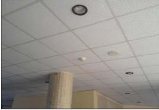
شكل (٧٤-٣) صور توضح وحدات الحريق الموجودة في كل الأدوار وتجهيز السقف بهذه الوحدات كما يوجد بالسقف سماعات للاذاعة الداخلية ووحدات الاضاءة
