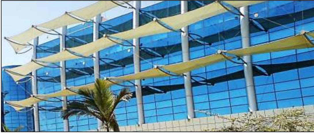
شكل (١٠٦-٢) الدعامات المعدنية التي تأخذ شكل عين والتي يتم شد الوحدات النسيجية عليها والتي تحمل بدورها علي أعمدة معدنية مستديرة structure cable، وكذلك توضيح ألواح التوصيل المعدنية التي يتم من خلالها تثبيت الكابلات المعدنية بالحائط stainless steel link plate - المصدر: الباحث
