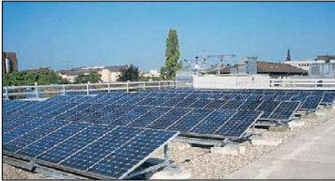
شكل (٢-٦٧) ألواح الفوتوفولتيك فوق سقف مبنى شركة التأمين suva بسويسرا يمد المبنى بـ ١٠.٢ كيلو واط من الكهرباء المصدر: j, wigginton, m & harris, "intelligent skins",
