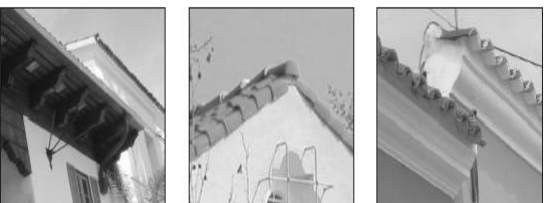
٣. اتصال السقف مع الحوائط: أ. يمكن للحوائط أن تتصل بالسقف من خلال كورنيش خشبي بارز، أو نماذج من المصيص أو القرميد
