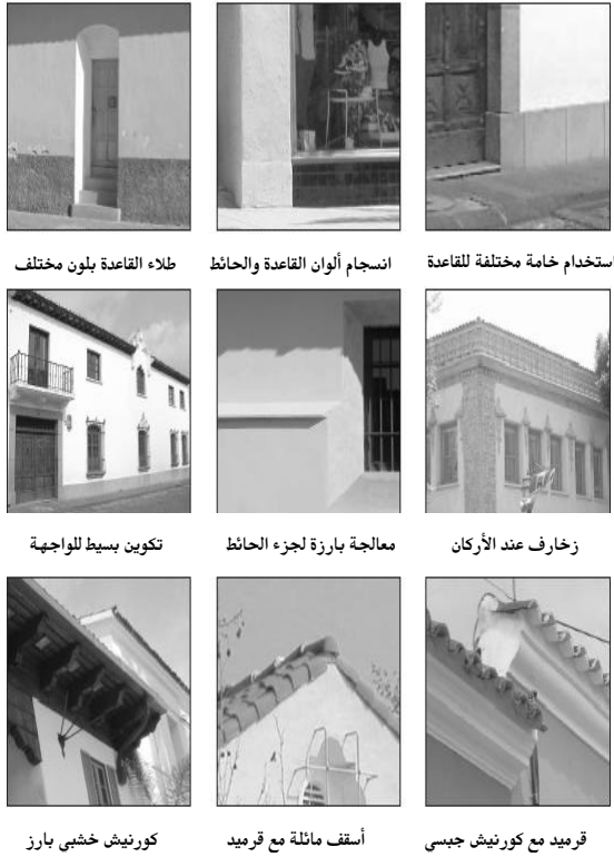
تكوين بسيط للواجهة معالجة بارزة لجزء الحائط زخارف عند الأركان قرميد مع كورنيش جبسي أسقف مائلة مع قرميد كورنيش خشبي بارز
