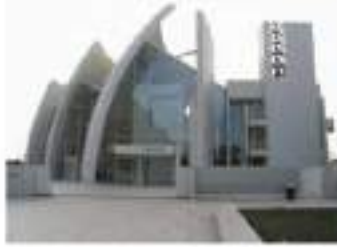
شكل (٤-٤) استخدام ثاني أكسيد التيتانيوم بالهيكل الخرساني للكنيسة لاجتبابها خاصية ذاتية التنظيف - لتقية الهواء - اللون الأبيض Source : http://www.archdaily.com/20105/church-of-2000-richard-meier/
