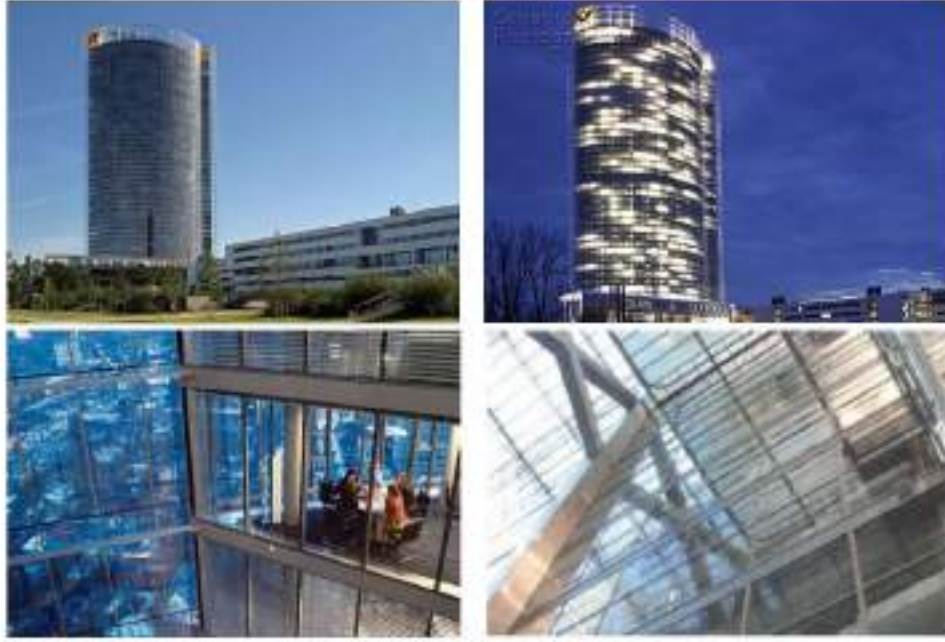
شكل (1-4) استخدام الزجاج المضاد للحريق في كامل الغلاف المبنى لمقر البريد الألماني source : Daniel L. Schodek , Nanomaterials , nanotechnologies and Design (2009),p184
