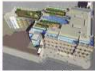
حديقة السطح ( Roof ) Garden بالمبنى كجزء من منظومة كفاءة الطاقة بالمبنى
