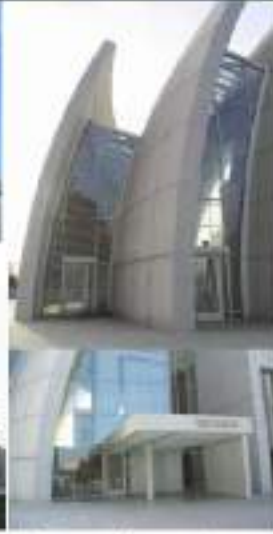
شكل (٤-٤) استخدام ثاني أكسيد التيتانيوم بالهيكل الخرساني للكنيسة لاجتبابها خاصية ذاتية التنظيف - لتقية الهواء - اللون الأبيض Source : http://www.archdaily.com/20105/church-of-2000-richard-meier/
