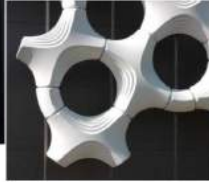
شكل (٣٠-٥) لوحات المبدئية الهندسية التي تغطي الواجهة المعلقة Source : http://www.medicaldaily.com/mexico-city-hospital-eats-pollution-torre-de-especialidades-features-innovate-facade-tiling-265942
