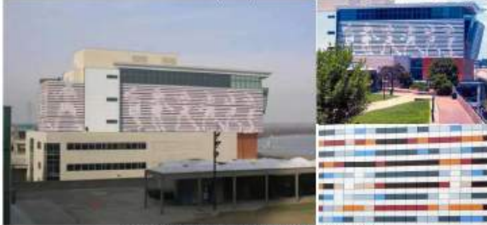
شكل (٢٣-٤) سيراميك الواجهات المعالج بطلاء التحفيز الضوئي
