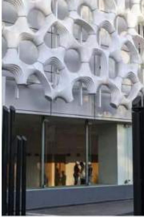
شكل (٣٠-٥) لوحات المبدئية الهندسية التي تغطي الواجهة المعلقة Source : http://www.medicaldaily.com/mexico-city-hospital-eats-pollution-torre-de-especialidades-features-innovate-facade-tiling-265942
