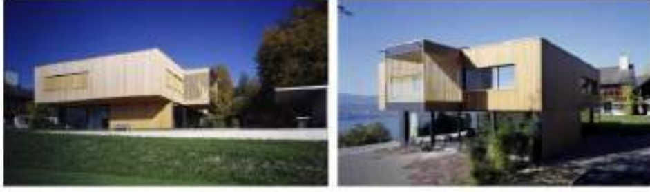
استخدام أخشاب النانو "Nano woods" بكامل واجهات المبنى
