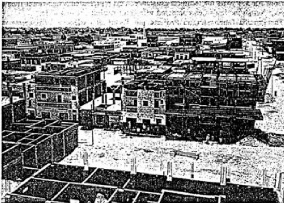
Recent housing construction in the new development area of Hai el Salam تطوير إنشاء المباني مع مشروع التسليم السلام
