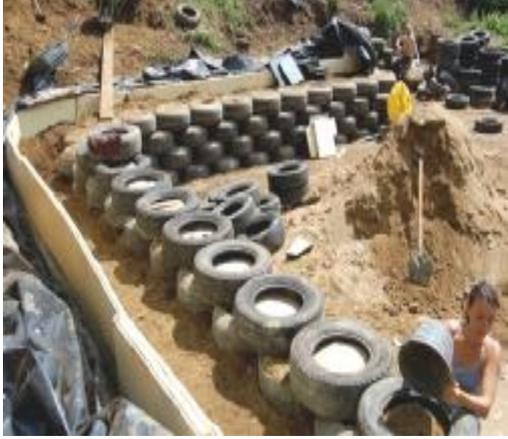
شكل (٣-٥) بناء المدمك الأول من الإطارات القديمة ثم صب التربة داخلها كعازل حراري وإنشائي - [www.channel4.com](http://www.channel4.com)
