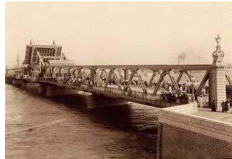
شكل رقم ( ١٠٦/١ ) كوبري بولاق ابو العلا - عام ١٩١٢ ويظهر استخدام قطاعات الحديد الصلب في انشاء الكوبري .
