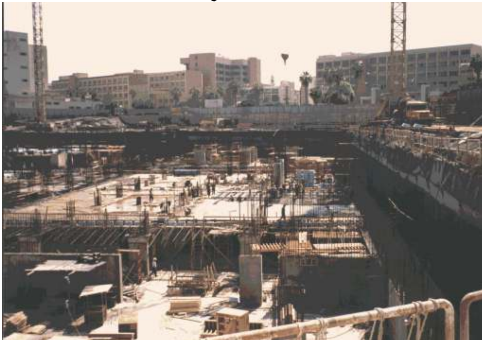
شكل (٧٧/٣) تفصيلية توضح معالجة المبنى من اخطار المياه الجوفية بالحناط الساند المزدوج
