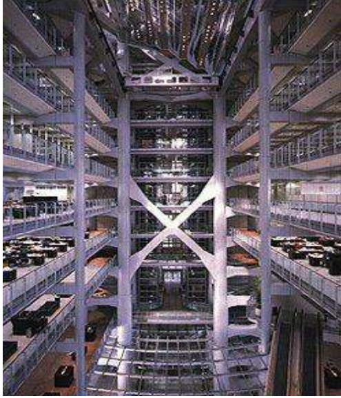
شكل رقم (78/1) المقر الرئيسي لبنك هونغ كونج - نورمان فوستر لقطات توضح الهيكل الانشائي - والتشكيل المعماري بالحديد الصلب .
