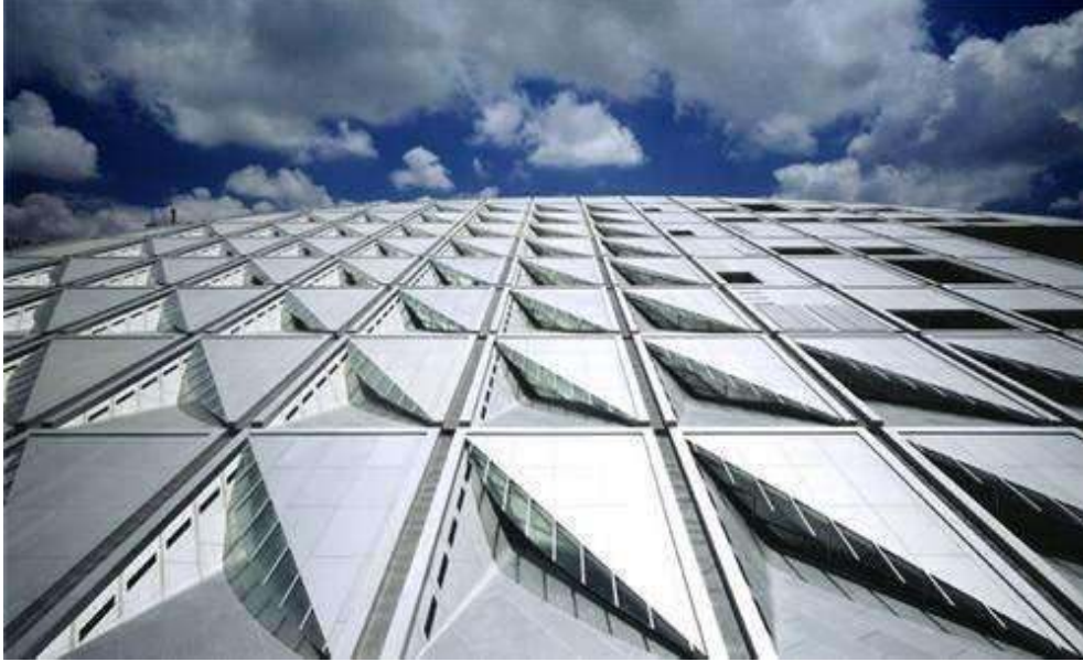
شكل(٧٤/٣)استخدم الزجاج والألومنيوم في تغطية سقف القرص المستدير المائل
