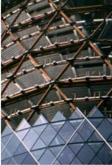
شكل (٣٩/٣) استخدام البلاطات بصورة مبتكرة على الواح من الصاج والهيك المعدني الخارجي اثناء التنفيذ
