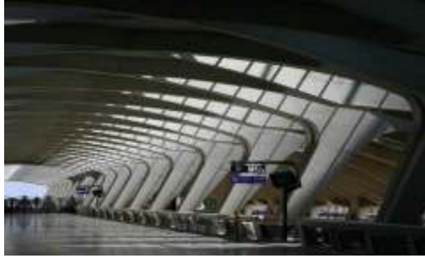
شكل(٢٣/٣) الاعصاب الداخلية مشكلة النظام الانشائي.
