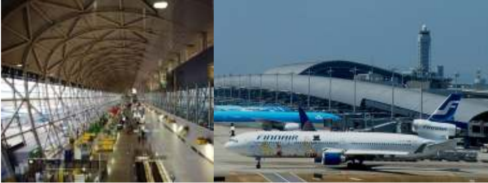
شكل رقم (٩٢/١) مطار Kansai باليابان - رينزو بيانو - ١٩٩٤م يظهر التغطية بالسقف الجمالوني المعدني المتموج .
