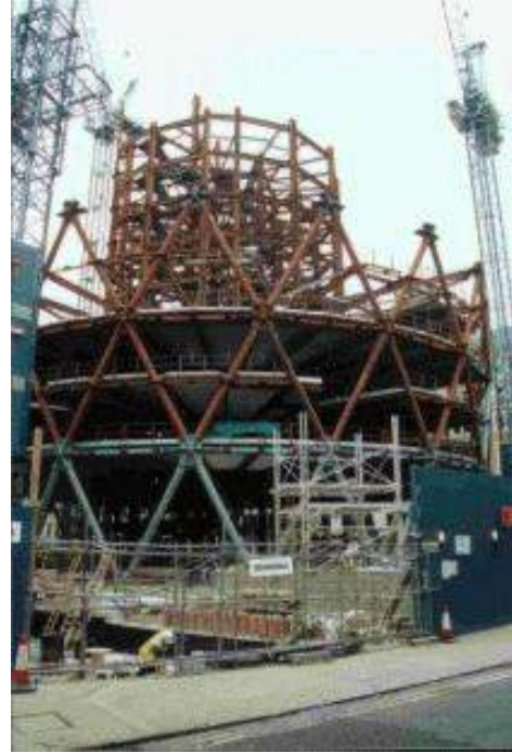
شكل (٣٩/٣) استخدام البلاطات بصورة مبتكرة على الواح من الصاج والهيك المعدني الخارجي اثناء التنفيذ
