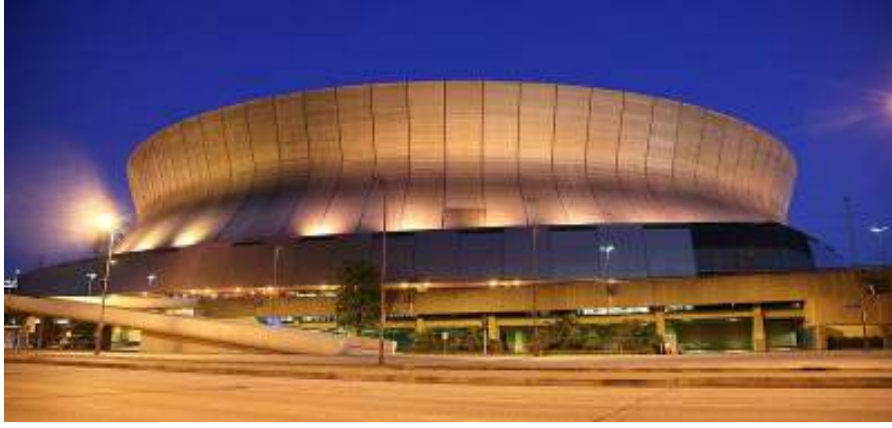
شكل رقم (٧/١) صالة الالعاب الرياضية في لويزيانا (Louisiana Superdome) عام ١٩٧٥ - أكبر منشأ من الصلب في تلك الفترة
