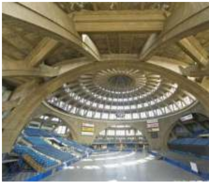
شكل رقم (٥٢/١) صالة مسرح الجيل – ألمانيا – ١٩١٢ م توضيح الصورة الاعصاب الداخلية من الخرسانة المسلحة
