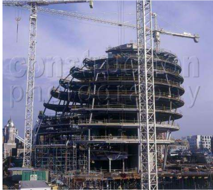
شكل(٥٣/٣) تم الاستعانة بثلاث أبراج ثابتة للمساعدة في سرعة تنفيذ المشروع
