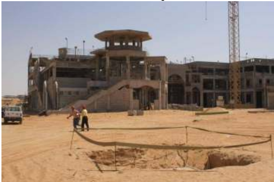
شكل (١٢١/٣) الخرسانة والمباني بالطوب من مواد البناء التي تم الاعتماد عليها في تنفيذ المشروع
