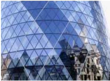
شكل رقم ( ٨١/١ ) مبنى المقر السويسري – نورمان فوستر التغليف الكامل للمبنى بالزجاج المتكيف بينيا
