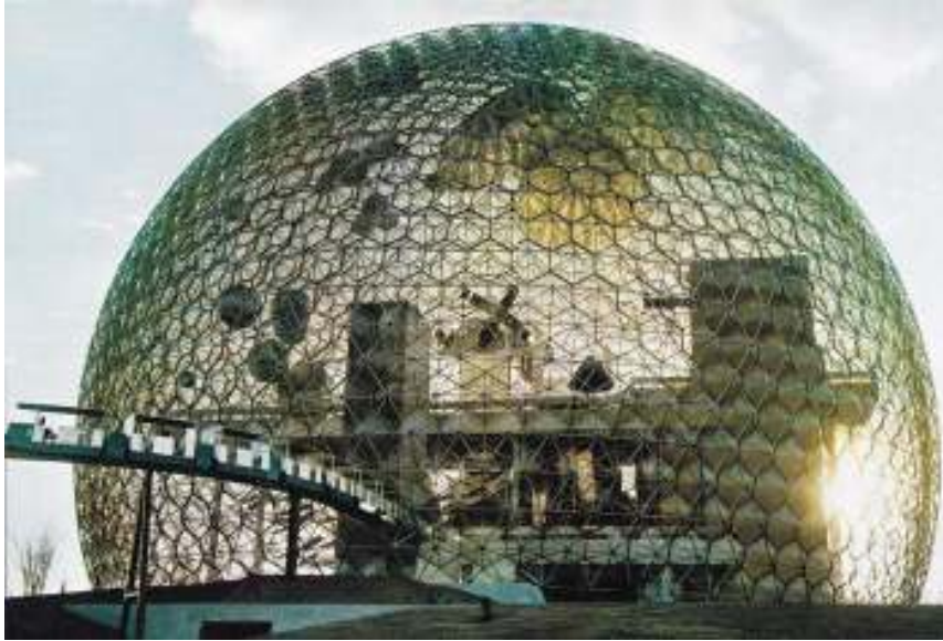
شكل رقم (٦٤/١) القبة الجيوديسية تمثل قمة الابداع الانشائي لـ Fuller والتي الهبت خيال المعماريين وغير المعماريين .
