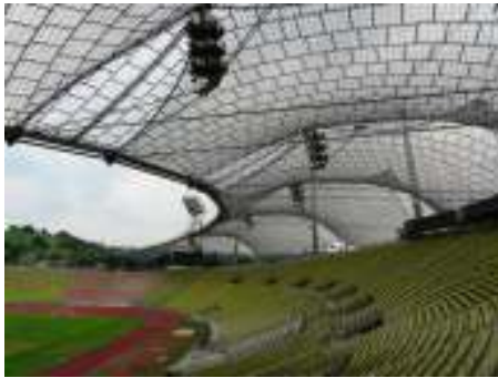
شكل رقم ( ٨٣/١ ) تغطية استاد ميونخ الاولمبي – بواسطة اللدائن
