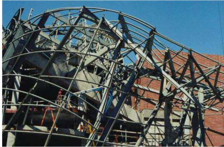
شكل(٢٨/٢) متحف جوجنهايم بلباو - الهيكل الشبكي - في الطبيعة
