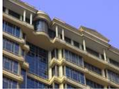
شكل رقم ( 113/١ ) استخدام مادة الـ G.R.C فى تكسية الواجهات - مبني فريست السكني
