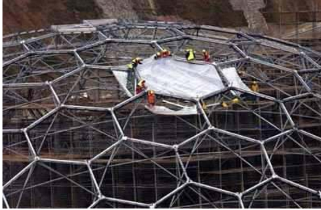
شكل(٣٢/٣) الوحدات السداسية المصنعة من الحديد الصلب وذلك اثناء تنفيذ المشروع
