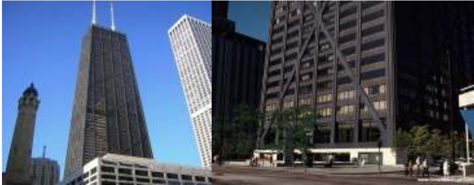
شكل رقم (٨٦/١) برج John Hancock Center - ١٩٦٩ م تظهر بة مقاومات الرياح فى الواجهات .
