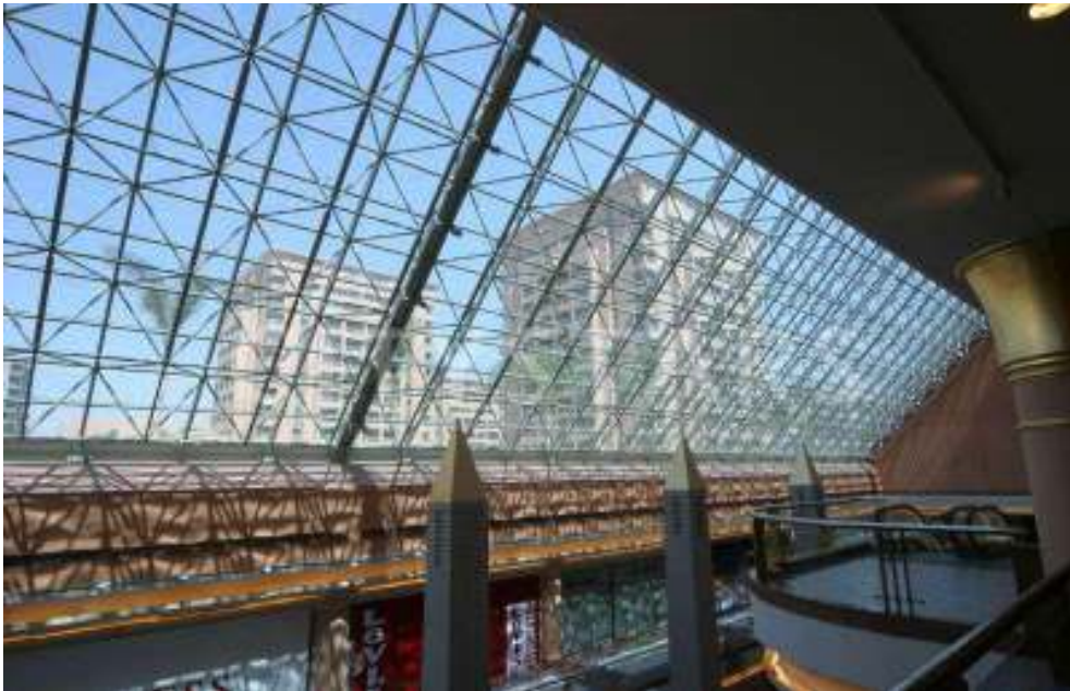
شكل(٨٩/٣) استخدام الجمالونات الفراغية مع البولي كربونيت شيت في تغطية الفراغات متعددة الارتفاع ( الاتريم )
