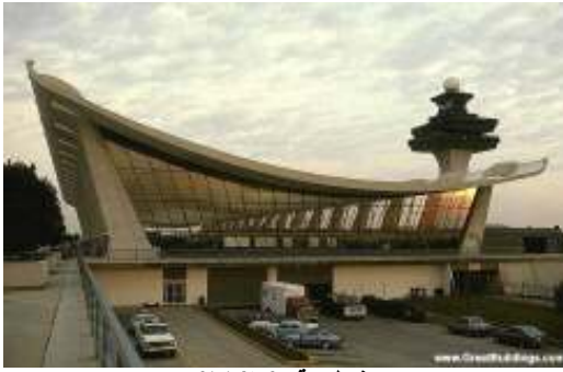
شكل رقم (٨٨/١) مطار دالاس - ١٩٦٢م - Eero Saarinen السقف القشري المنحني المدعم بكابلات
