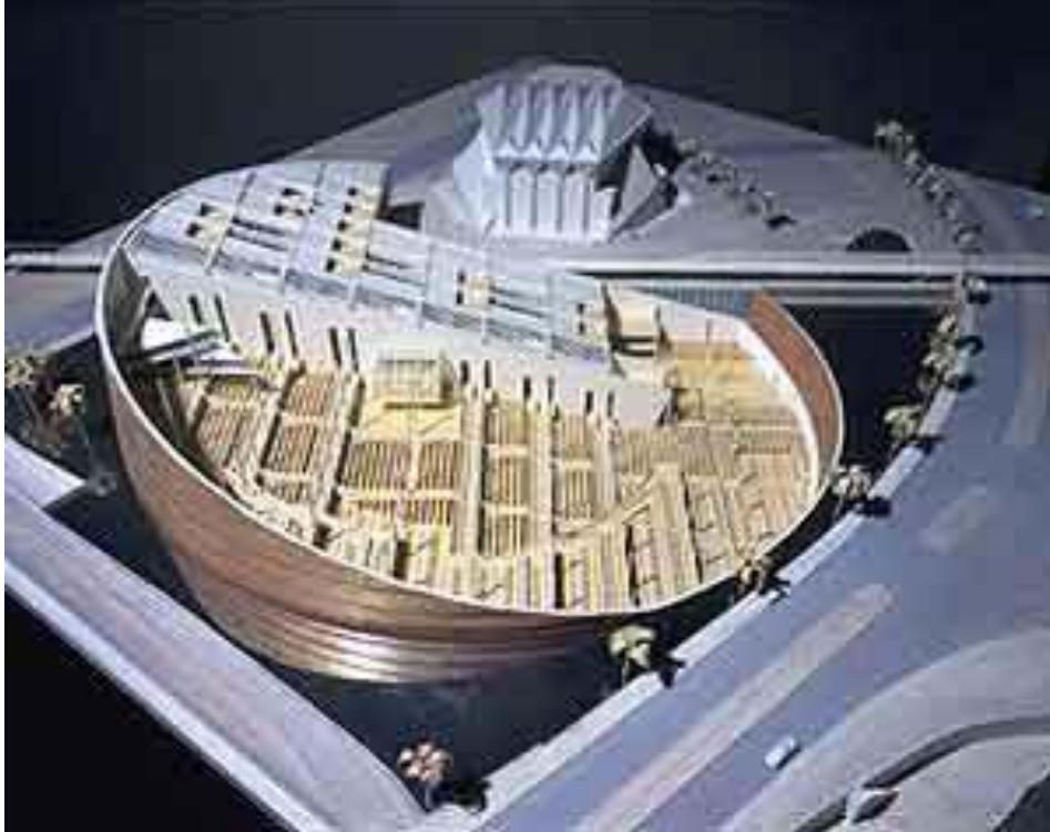
شكل (٦٥/٣) ماكيت مشروع مكتبة الاسكندرية - يوضح التدرج الداخلي لصالات القراءة للاستفادة من الاضاءة الخارجية .
