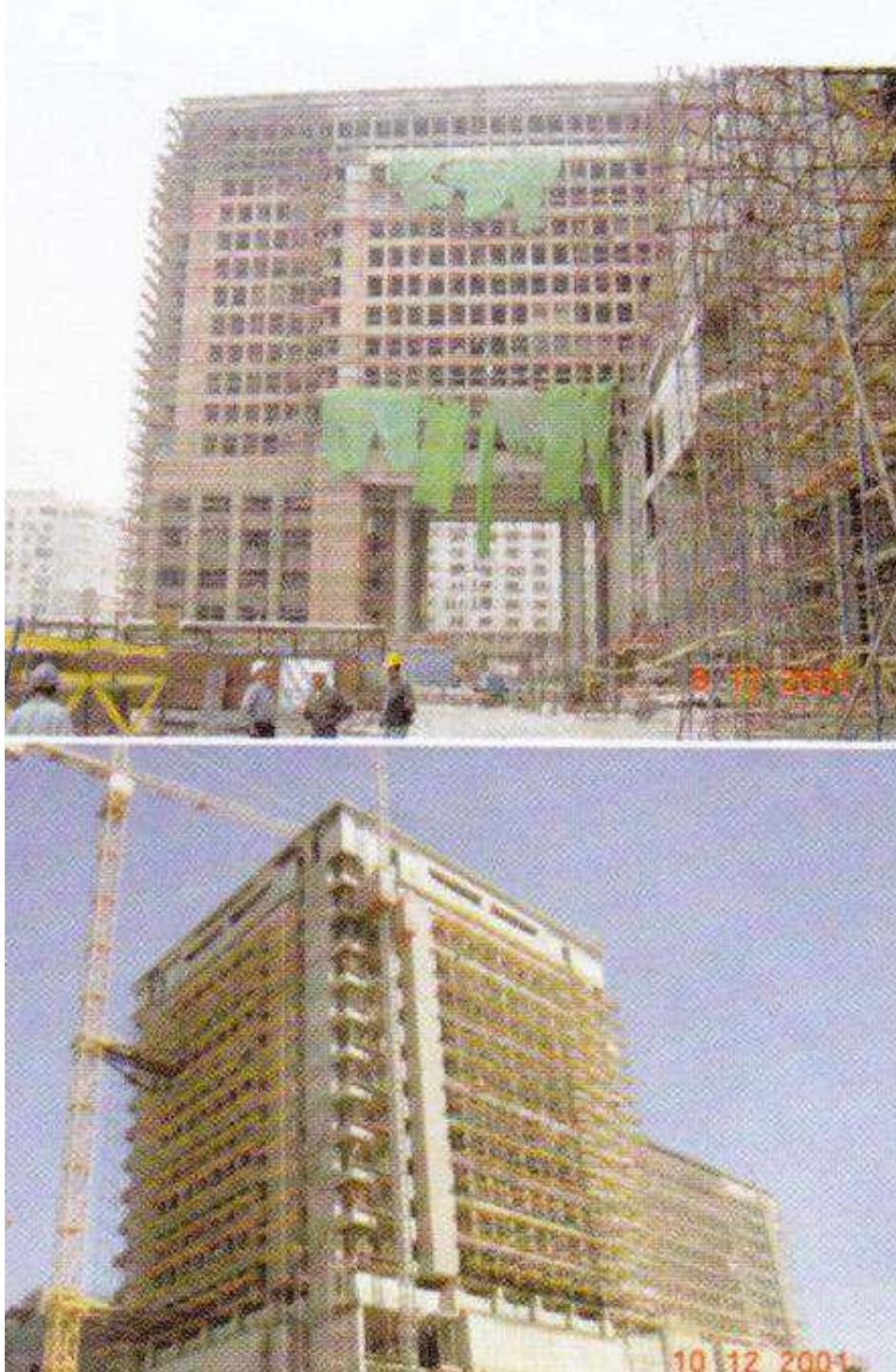
شكل (٩٠/٣) استخدام الاوناش البرجية للتخديم داخل الموقع والشدات المعدنية لاعمال تكسية الواجهات
