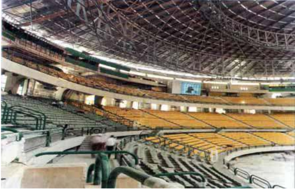
شكل (٦٢/٣) لقطة داخلية توضح النظام الإنشائي لتغطية سقف الصالة الرئيسية مجمع الصالات المغطاة مدينة نصر - القاهرة
