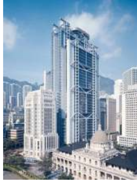
شكل رقم (78/1) المقر الرئيسي لبنك هونغ كونج - نورمان فوستر لقطات توضح الهيكل الانشائي - والتشكيل المعماري بالحديد الصلب .
