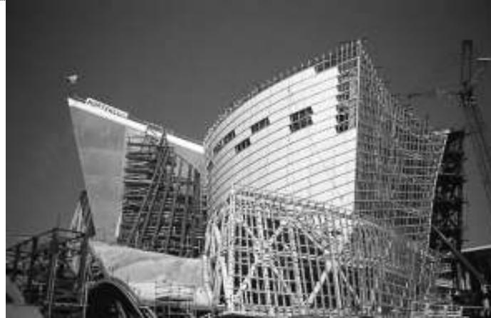
شكل (١١/٣) لقطة توضح الهيكل الإنشائي المعدني من الحديد الصلب اثناء التنفيذ اعمال التكسية الحديثة للمبني من الاستانليس – تاثر اعمال فرانك جيري بالتطور التكنولوجي في القرن الـ ٢١
