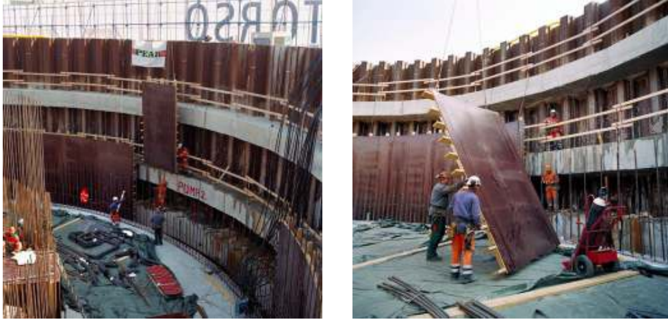
شكل رقم ( ١١٩/١ ) الشدات المعدنية - احد اساليب التنفيذ
