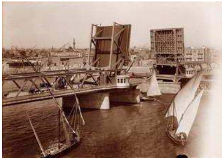
شكل رقم ( ١٠٦/١ ) كوبري بولاق ابو العلا - عام ١٩١٢ ويظهر استخدام قطاعات الحديد الصلب في انشاء الكوبري .
