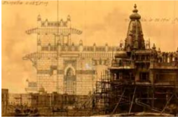
شكل رقم ( ١٠٩/١ ) استخدام الشدات الخشبية التقليدية في تنفيذ مدينة مصر الجديدة
