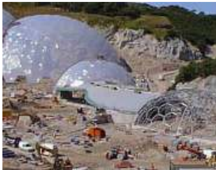
شكل(٣٢/٣) الوحدات السداسية المصنعة من الحديد الصلب وذلك اثناء تنفيذ المشروع
