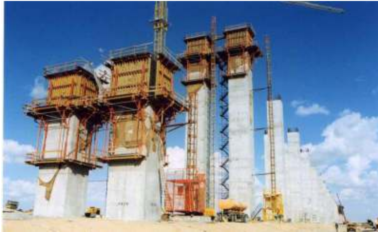
شكل رقم ( ١٢٠/١ ) نظام الشدات المنزقة - في تنفيذ كور المبني
