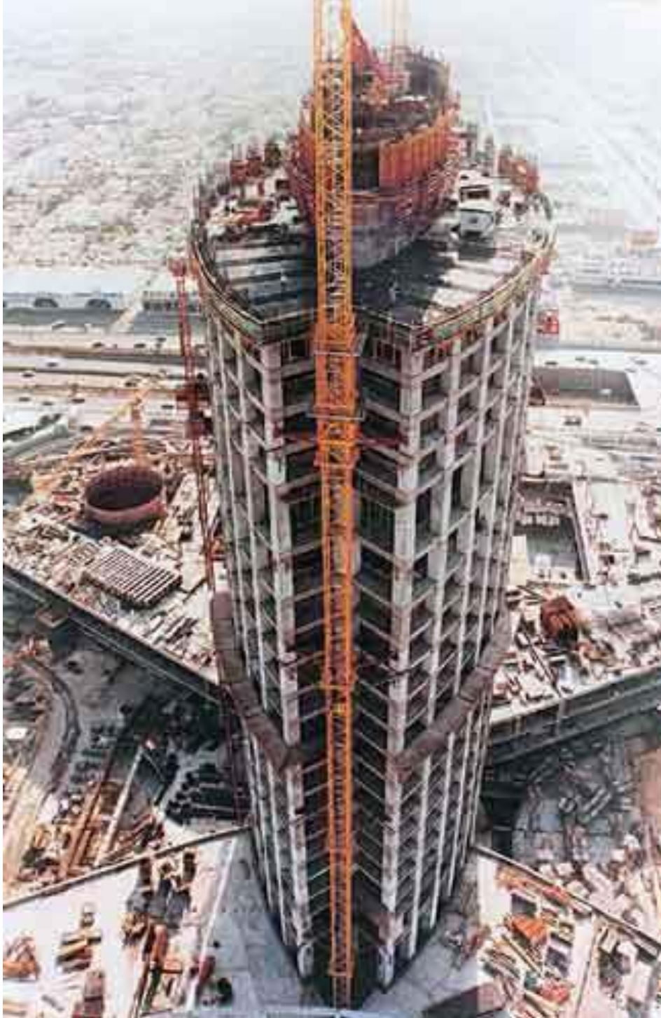
شكل (٩٥/٣) المبني اثناء التنفيذ. يتضح الهيكل الاتشائي الخرساني - ثم الهيكل المعدني للجزء العلوي
