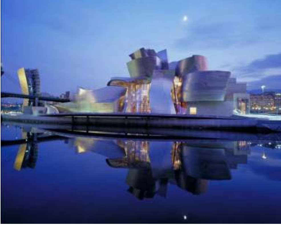
شكل (٢٥/٣) لقطة خارجية توضح التصميم والموقع المميز لمتحف جوجنهايم - بلباو - اسبانيا للمعماري العالمي / فرانك جيري
