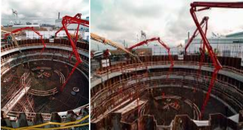
شكل رقم ( ١١٨/١ ) استخدام وسائل الصب الحديثة - المظخات المركزية
