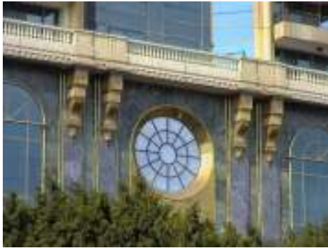
شكل رقم ( 113/١ ) استخدام مادة الـ G.R.C فى تكسية الواجهات - مبني فريست السكني
