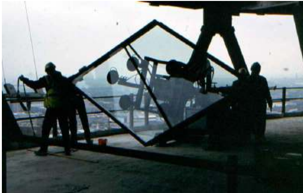
شكل (٤٠/٣) لقطة توضح استخدام الوحدات الزجاجية اثناء التركيب ببرج (ReSwiss)
