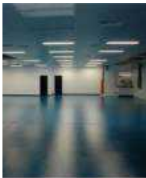
شكل(٣-٨٣): بلاطات الإيبوكسي المستخدمة في معمل الإكياي بالدور الأول بالمبنى.
