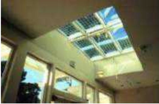
شكل(٢-٨٤): استخدام الخلايا الضوئية في أفنية السماء
