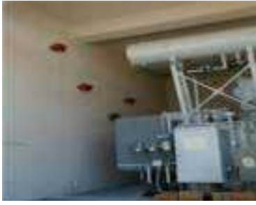
شكل(٣-٥٦): نظام الإطفاء بالأيروسول المستخدم في غرفه المحولات
