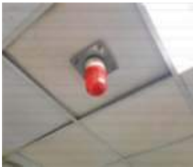
شكل (٣-٥٢): وحدة Alarm المسؤولة عن إنقطاع الكهرباء في مكتب الوزير
