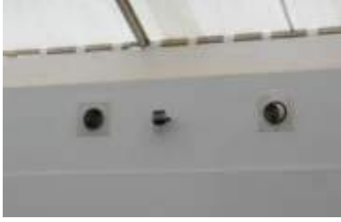
شكل(٩١-٣) وحدات Split لتوزيع الهواء من ماكينة التكييف المركزي بداخل المبنى بالكامل
