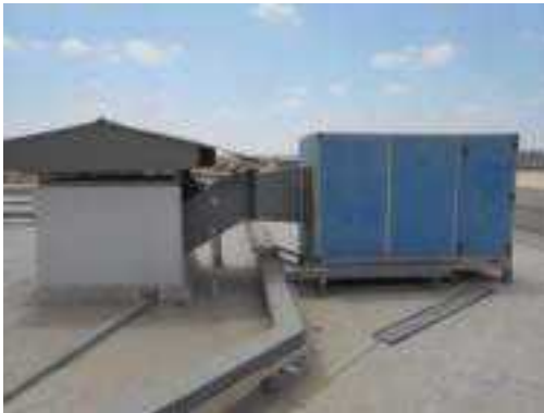
شكل (٣-١٤٧): ماكينة Fresh Air المستخدمة
