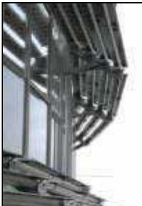
شكل(٢-٥٩): الشرائح الأفقية المستخدمة من نظام الفوتوفولتك للتظليل
