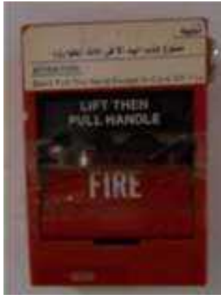
شكل (٦١-٣): Fire Alarm لمعرفة مكان الحريق
