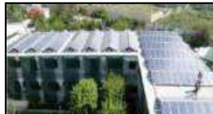
شكل(٨١-٢): استخدام الخلايا الضوئية في السقف المستوي
