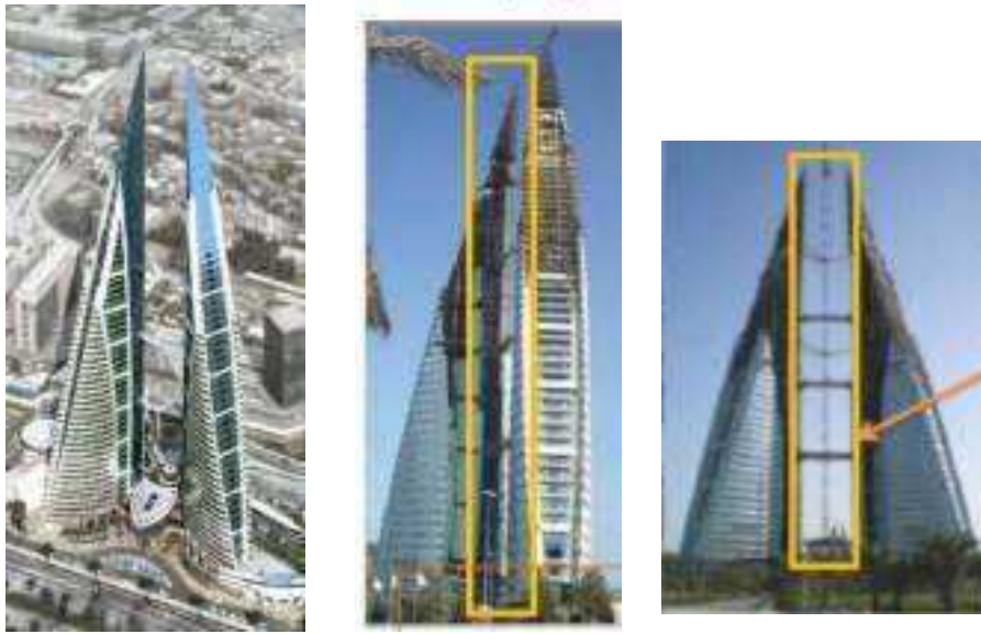
شكل(١٠٣-٢): يوضح التوربينات الثلاثة في المركز التجاري، ويمثل الشراعين المديبين الثلاث توربينات تدور بنفس سرعه الرياح
