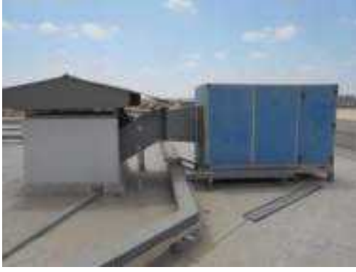
شكل (٣-٩٤): ماكينة Fresh Air المستخدمة للعيادات
