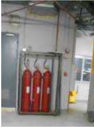
شكل (٣-١٠٥): إسطوانات غاز ثاني أكسيد الكربون المستخدم في غرف الكنترول
