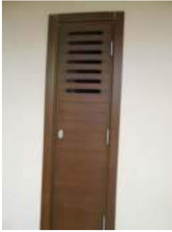
شكل (٩٢-٣): جهاز N-turn المستخدم لتجميع الهواء من المبنى ورجوعه الى التكييف المركزي
