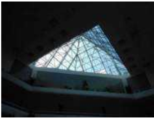
شكل (٣- ١٥): الهرم الزجاجي المستخدم لإنارة المدخل الرئيسي والقط الأفقية بالإضاءة الطبيعية
