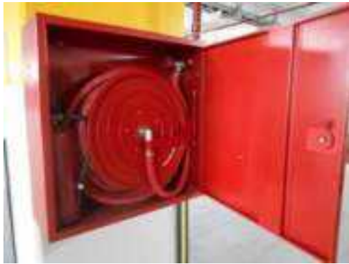
شكل (٣-١٠٦): صندوق المياه المستخدم في كل دور بالمبنى
