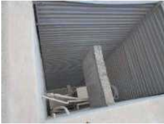
شكل (٣-٩٥): ماكينات كونسلد المتجمعة في الدكت لكل عيادة تكييف مستقل بذاته
