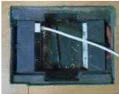
شكل(٢١-٣): صور مخارج Packet Switching بالأرضيات
