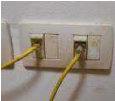
شكل(٢٢-٣): صور مخارج Packet Switching بالحائط
