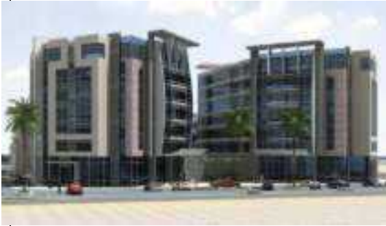
شكل (٣-١٠٠): الواجهه الخلفية للمبنى الطبي توضح
