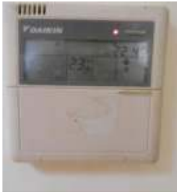
شكل (٣-١٤٦): وحدة تحكم في الوحدات الداخلية لنظام VRV
