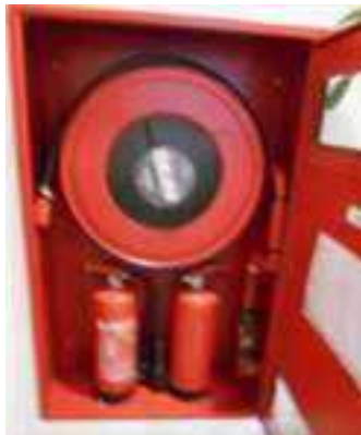
شكل(٣-٥٩): صناديق الحريق المستخدم بكل دور
