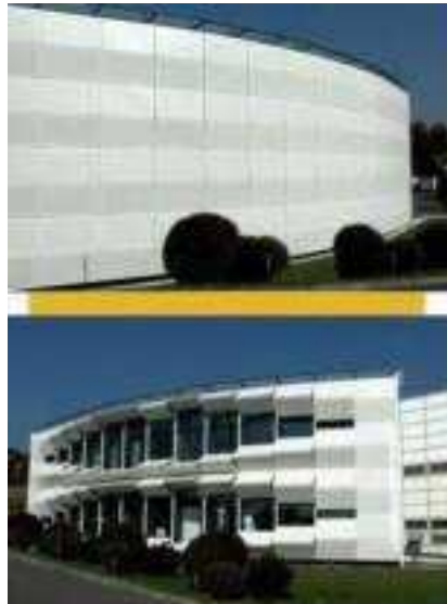
شكل (٢-٥٣): تغيير الواجهة بصفة مستمرة كل يوم وكل ساعة للوقاية من الشمس
