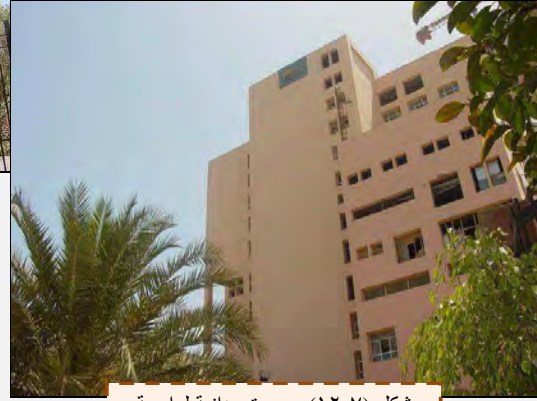
شكل (٧-١٢) صورة ميدانية لواجهة المركز (١).
