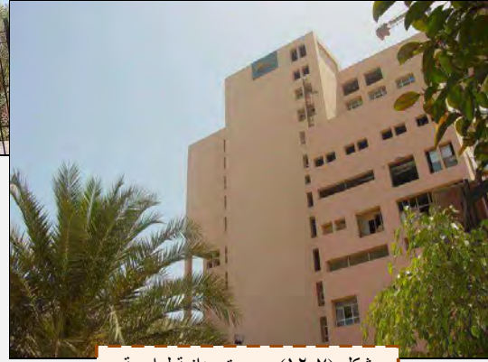
شكل (٧-١٢) صورة ميدانية لواجهة المركز (١).
