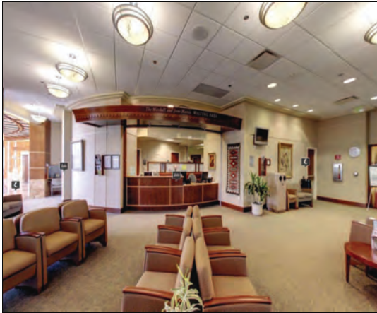
شكل (٨-٥) استخدام الأسقف المعلقة المعدنية بفراغ انتظار بمعهد هنتسمان للسرطان (١)
