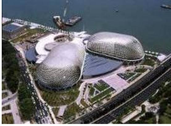
الشكل رقم (١-١-١٤) يوضح شبكة الأصداف المَقَوَّسة grid shell المكون الرئيسي للغلاف الخارجي للمركز
