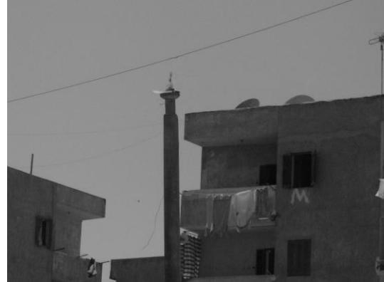
شكل (٣-٥٨) أحد أعمدة الإنارة بلا وحدة إضاءة "الحي الثاني المجاورة الرابعة" (المصدر: الباحثة)
