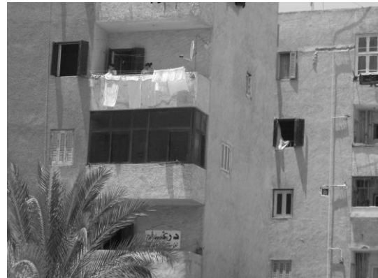
شكل (٣-٨) إغلاق البلكونة كأحد تعديلات السكان في وحداتهم الحي الثاني المجاورة الرابعة (المصدر: الباحثة)
