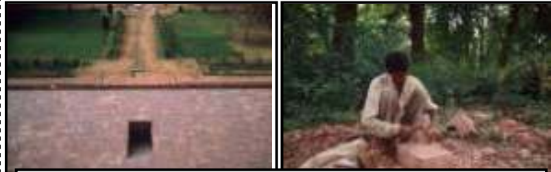
شكل (٣-٣-٥) : أعمال ترميم المسارات داخل الحديقة- المصدر : www.archnet.org
