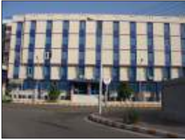
شكل (٤-١١) يوضح مستشفى الهلال. المصدر: بواسطة الباحثة
