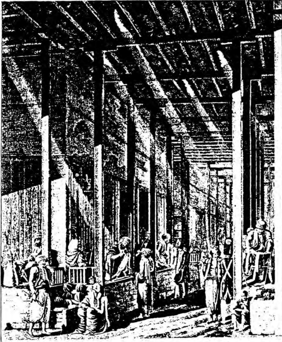
شكل ( ٣٧ ) أسلوب تغطية الأسواق في القاهرة القديمة بواسطة الأسقف الخشبية ويظهر أيضاً
