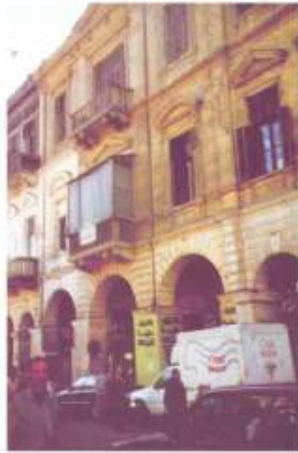
شكل ٣-١٠ شارع محمد علي باشا ( القلعة ) تم انشاؤه عام ١٨٧٢ وقد أضيء كاملاً بالمصابيح الغازية ١
