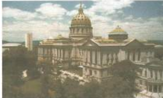
شكل ٣١-١ مبنى برلمان ولاية بنسلفانيا – بنسلفانيا – أمريكا التكملة للأجزاء الناقصة والمفقودة
