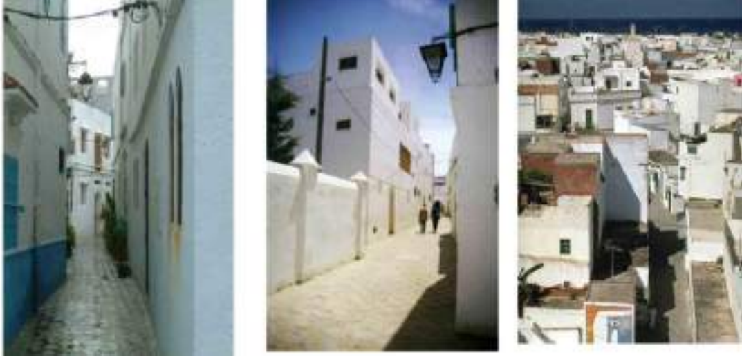
شكل ٢-١٢ لقطات توضح المباني التراثية الموجودة وعملية الترميم والتبليطات الجديدة بممرات المدينة المصدر :
