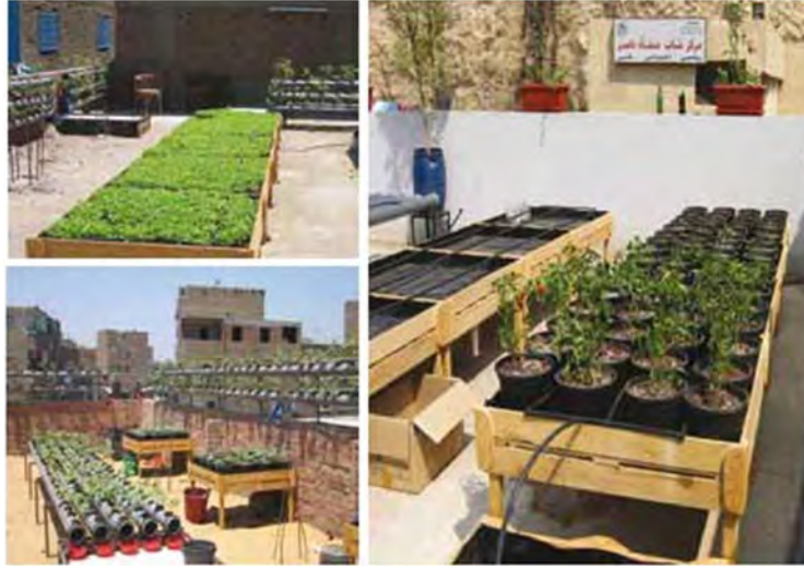
شكل (٢٠/٥) النموذج الإسترشادي الذي تم تنفيذه بمنشأة ناصر لتوضيح فكرة تحويل السطح الي حديقة مثمرة ١٨٠
