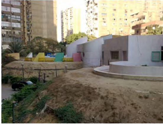
شكل (١٧/٥): حضنة أكاديمية الطفل، حيث يظهر شكل الفصول الواقعة داخل القبو تحت مستوى الأرض والسطح المزروع حاليا بحالة رديئة لعدم متابعة الصيانة ١٧٣
