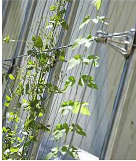
شكل (٢٢/٤) توضح وصلات المشابك الصليبية في نظام الكابلات ١٢٩
