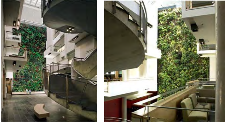
شكل (٣٢/٤) مبني جامعة Guelph Humber احد نماذج الحوائط الحية التي يصل ارتفاعها الي اربعة ادوار، تاريخ الإنشاء مايو ٢٠٠٤ ١٤٦
