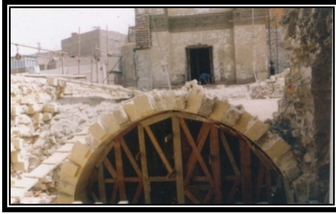
شكل (٣-١-١٧) إعادة إنشاء القبوات الحاملة للحرامك
