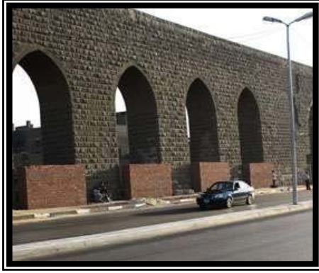
شكل رقم (١-٣-١٨) إعادة بناء بعض الأجزاء المفقودة بسور مجري العيون
