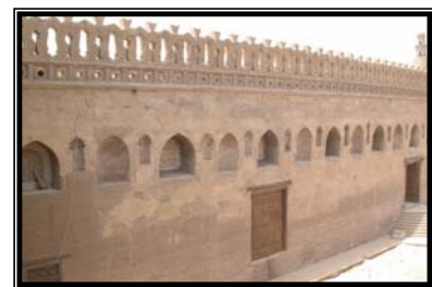
شكل (٦-٣-١) عوامل تلف وتدهور طبقات البياض (الشيد) التي تكسو جدران الأسوار لجامع أحمد بن طولون
