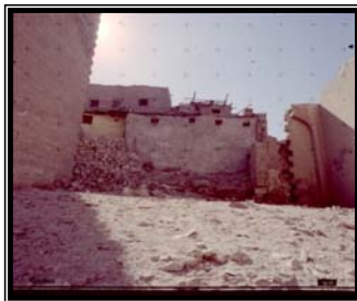
شكل (٧-٣-١) صورة توضح تعدي المباني المجاورة وكذلك طرف رباط لأحد حوائط البيمارستان
