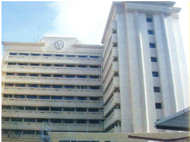
شكل ٣٦-٤ استخدام تقنيات الخرسانة المزججة - وزارة الداخلية - القاهرة - مصر
