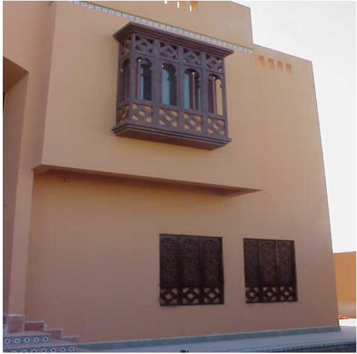
شكل ٢٩-٤ استخدام تقنيات الخرسانة المزججة في تأصيل القيم الجمالية للعمل المعماري. - فيلا - جدة
