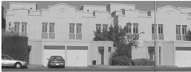
شكل ١١-٣ بانوهات الخرسانة السابقة التجهيز لكسوة الواجهات – جدة - السعودية
