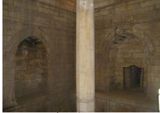
صورة رقم 448 أنفاق المياه المصدر: الباحثة.
