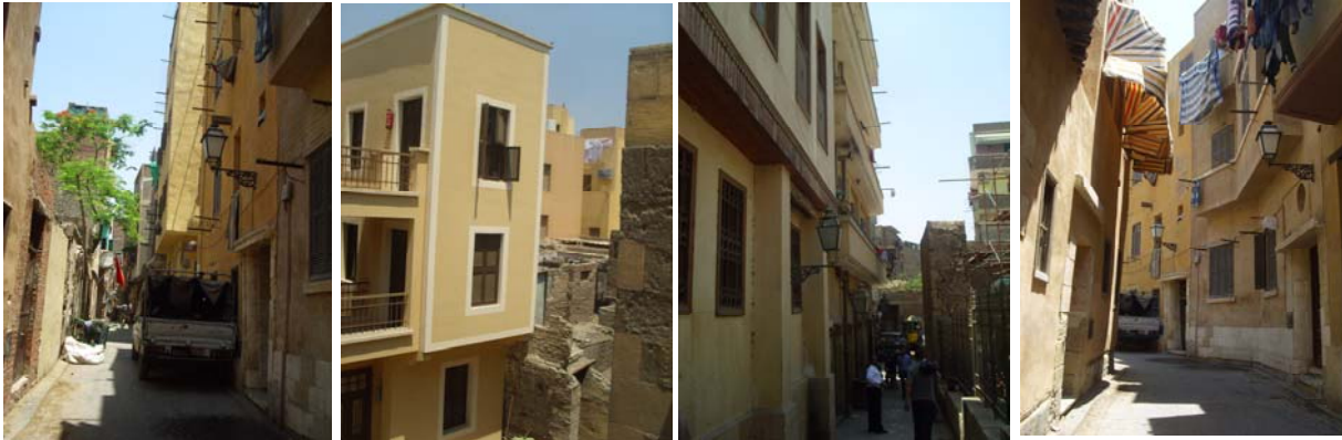
صور رقم 378, 379, 380, 381 مباني منطقة الدرب الأحمر و دروبها بعد التطوير المصدر: الباحثة.
