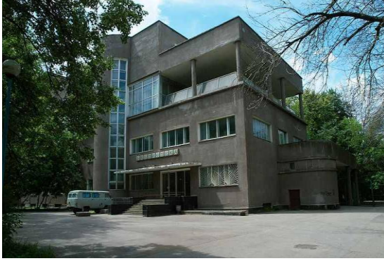
شكل ( ١ - ٢١ ) مجمع مباني قصر الثقافة لمصانع ليخاجيوف للسيارات في موسكو ١٩٣١ ( جناح المكتبة ) ( ٣ )
