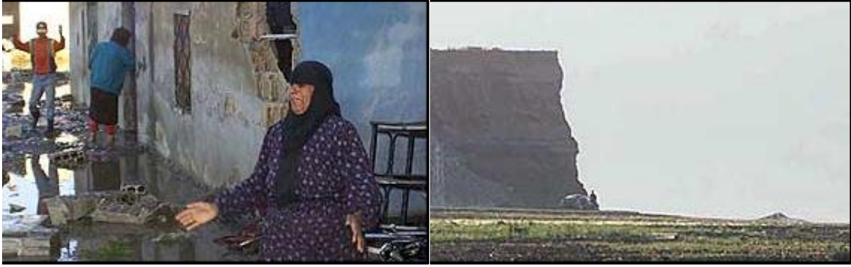
شكل (١) : سد " زيزون " بسوريا عقب إنهياره عام ٢٠٠٢ شكل (٢) : إحدى القرى بسوريا التي أصابها الدمار بسبب كارثة إنهيار سد " زيزون " عقب رجوع سكانها إليها (٧) وغرق عدة قرى (٧)
