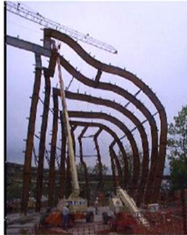
شكل : ٥ شكل يوضح : الهيكل الإنشائي لمشروع الإحساس بالموسيقى، والذي استخدمت طرق التقطيع الثاني والثلاثي الأبعاد، في تنفيذه.
