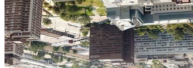
شكل ( 2-11 ) يوضح منظور ومسقط افقي لمدرسة تم تصميم المبنى على مفهوم تشكيل المدينة-المصدر :
