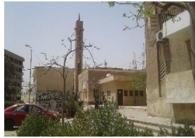
شكل ( ٥ - ٤٤ ب ) يوضح غرفة الكهرباء مجاور (جنوب غربي) المدرسة والمسجد - المصدر: الباحثة
