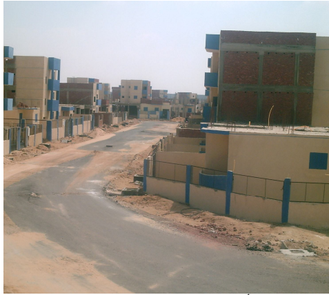
شكل (24) : أحد الشوارع الداخلية ويظهر بمعظم قطع الأراضى إكمال بناء الدور الأرضى (2010/3/27)
