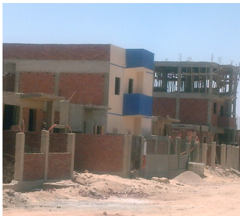
شكل (20) : يوضح إختلاف درجة الإنجاز بين قطع الأراضى بإكتمال الدور الأرضى بمراحله الثلاث وكذلك الدور الأول ببعض القطع بينما القطع الأخرى لم تنتهى من المرحلة الثالثة وهى التشطيب الخارجى ( 2009-6-14 )
