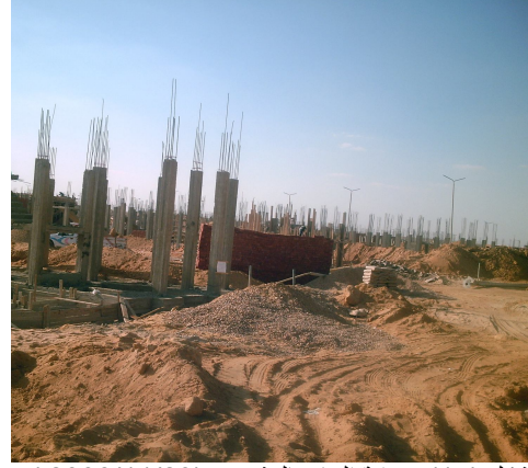
شكل (17) : بداية البناء بالمشروع (2008/11/23) قبل الإنتهاء من المرحلة الأولى ( الأساسات وأعمدة الدور الأرضى )
