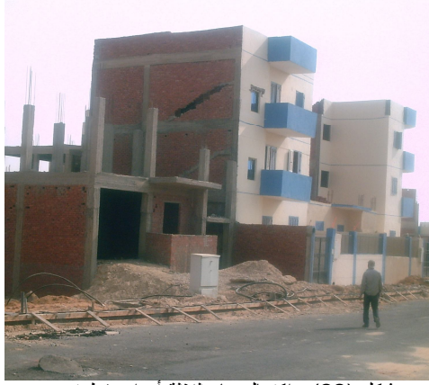
شكل (22) : إكمال بناء ثلاثة أدوار بقطعتين متجاورتين وتظهر أعمال الرصف
