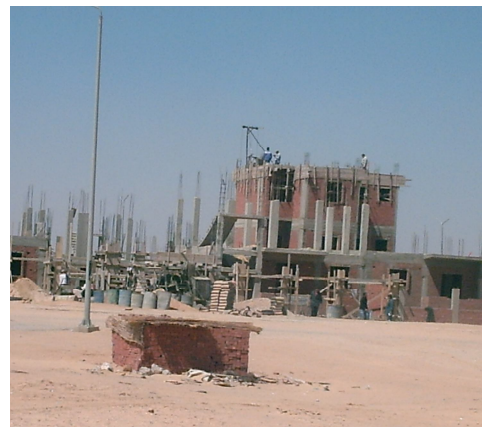
شكل (19) : تطور البناء بالموقع ( 2009-3-31 )
