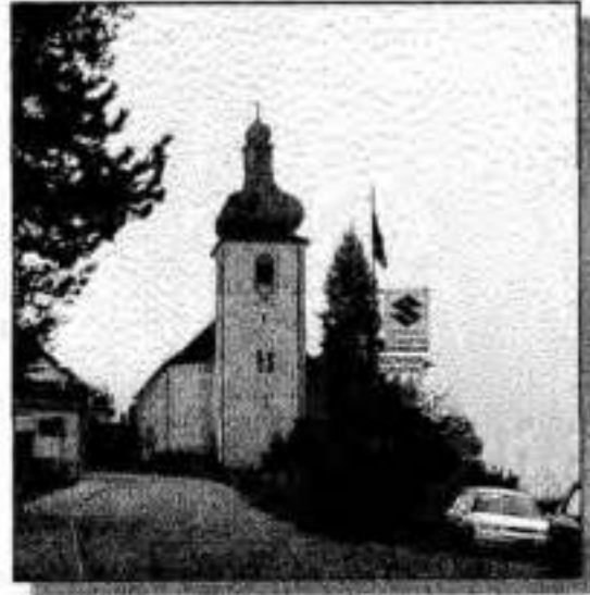
شكل ( ١٣٣ ) يظهر برج الكنيسة التي تم تركيب محطة تقوية الإرسال فيه في قرية همبرج
