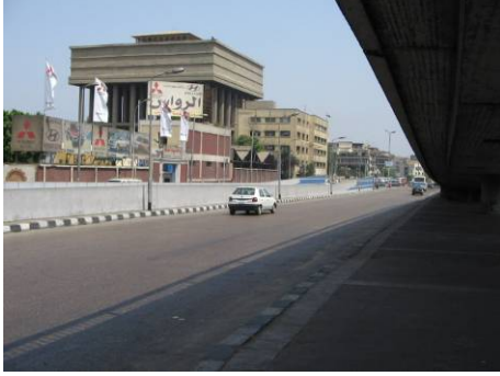
صورة ( ٧٧ ) خزان مياه امبابه المصدر : الباحث , ٢٠٠٥
