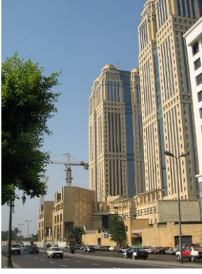
صورة (٦٥) فندق نايل سيتي تحت الإنشاء المصدر : الباحث , ٢٠٠٥
