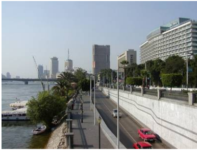
صورة (١٠٣) مبني النيل هيلتون المصدر : الباحث , ٢٠٠٥
