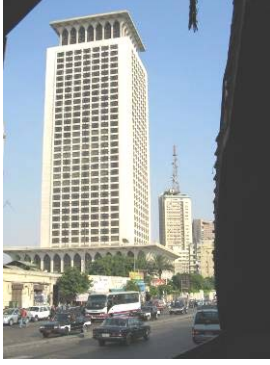
صورة (٨٠) مبني وزارة الخارجية المصدر : الباحث . ٢٠٠٥
