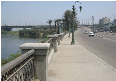
صورة (٥٦) منزل كوبري روض الفرج المصدر : الباحث , ٢٠٠٥
