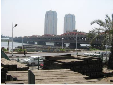
صورة (٥٢) الحد الجنوبي لمنطقة الدراسة " كوبري إمبابة " المصدر : الباحث , ٢٠٠٥
