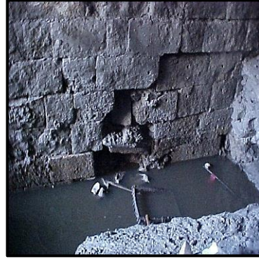
شكل ٤٧-١: تفتت الأحجار نتيجة للمياه الجوفية (قصر الأمير بشتاك - حى الجمالية) المصدر: الباحثة، ٢٠٠٣
