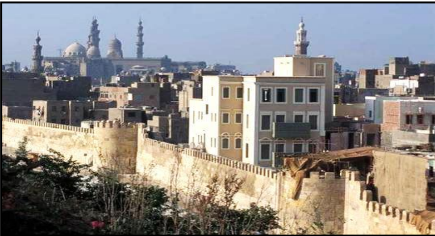
شكل ٣- ٨٧: السور الأيوبي قبل وأثناء وبعد أعمال الترميم
