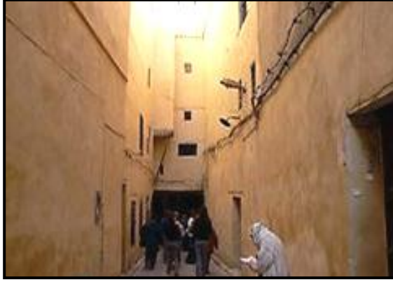
شكل ٣-١٢: بعض المباني السكنية بعد الترميم بمدينة فاس القديمة المصدر: http://maps.google.com/maps (2011)
