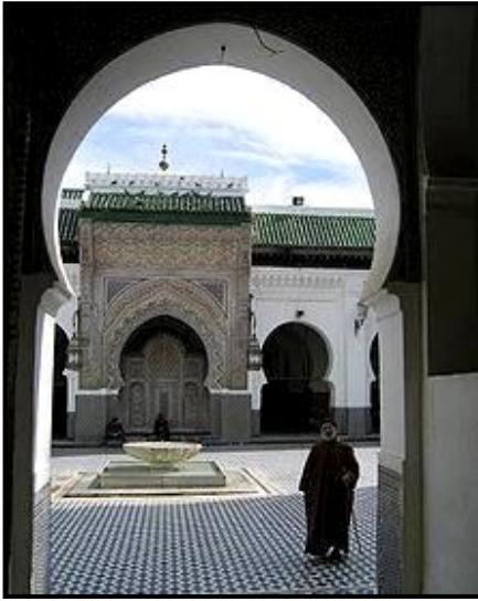
شكل ٣-١٤: إحدى بوابات مسجد القرويين بعد الترميم بمدينة فاس القديمة
