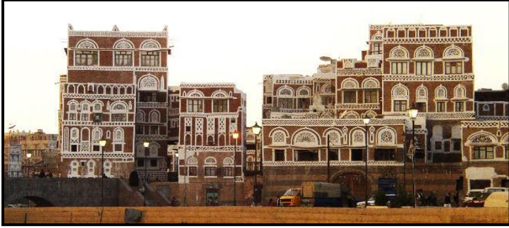
شكل ٣-٥٦: المباني بعد الترميم وأعمال الصيانة بمدينة صنعاء القديمة
