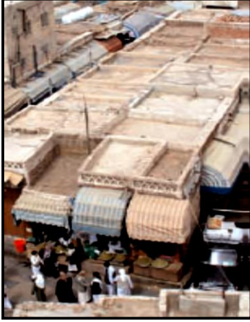
شكل ٣-٥٣: تدهور المباني في السوق بمدينة صنعاء القديمة
