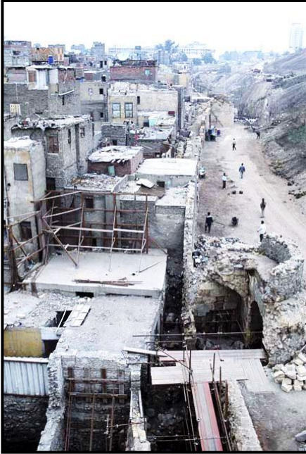
شكل ٣-٨٠: تدهور المباني الملاصقة للصور الأيوبي بمنطقة درب الأحمر
