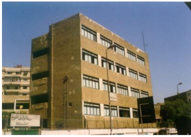
شكل ٧-٤٤: واجهه المبني الرئيسي
