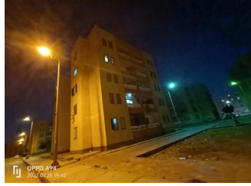
شكل ( ٢٨ ) يوضح لقطة توضح الواجهة التي تحوي عينة ٢ و٤ - المصدر : الباحثة
