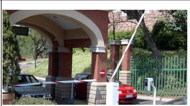
شكل ( ١٣ ) : نموذج لبوابة ذات أذرع Boom Gate تستخدم في المجتمعات المغلقة
