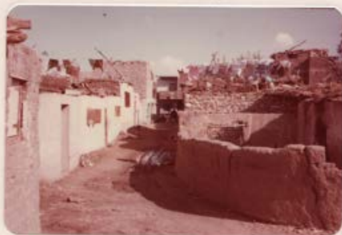
الشكل (٤-١١) منظر عام لبعض المساكن التي تطبعت بالمساكن الريفية التقليدية والمواد المستخدمة فيها .
