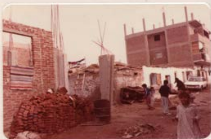
الشكل (٢-١٤) مواد البناء المستخدمة في إقامة العمارات السكنية بالجزء الشرقي من منطقة الدراسة .
