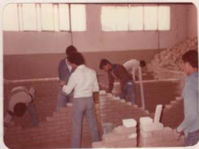
الشكل (٧٢-٣) العمال في مركز التدريب الحرفي أثناء تدريبهم على أعمال بناء الحوائط .
