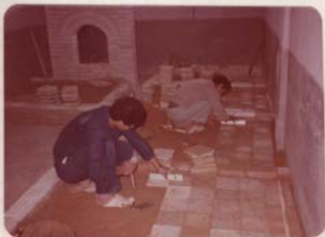
الشكل (٧٢-٢) العمال في مركز التدريب الحرفي أثناء تدريبهم على أعمال التليطات المختلفة .
