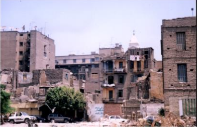
٥ شارع معروف وتظهر به المباني المتدهورة والمهدمة جزئياً منطقة معروف المتدهورة - قسم قصر النيل
