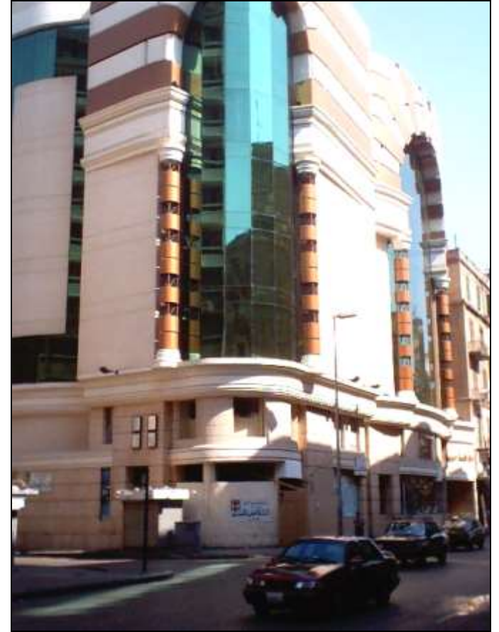
شكل ( ٤ - ٢٥ ) : مول " طلعت حرب " - قسم قصر النيل ٣٠ ش طلعت حرب - قسم قصر النيل يلاحظ عدم انسجام واجهات المبني مع الطابع التاريخي للمنطقة
