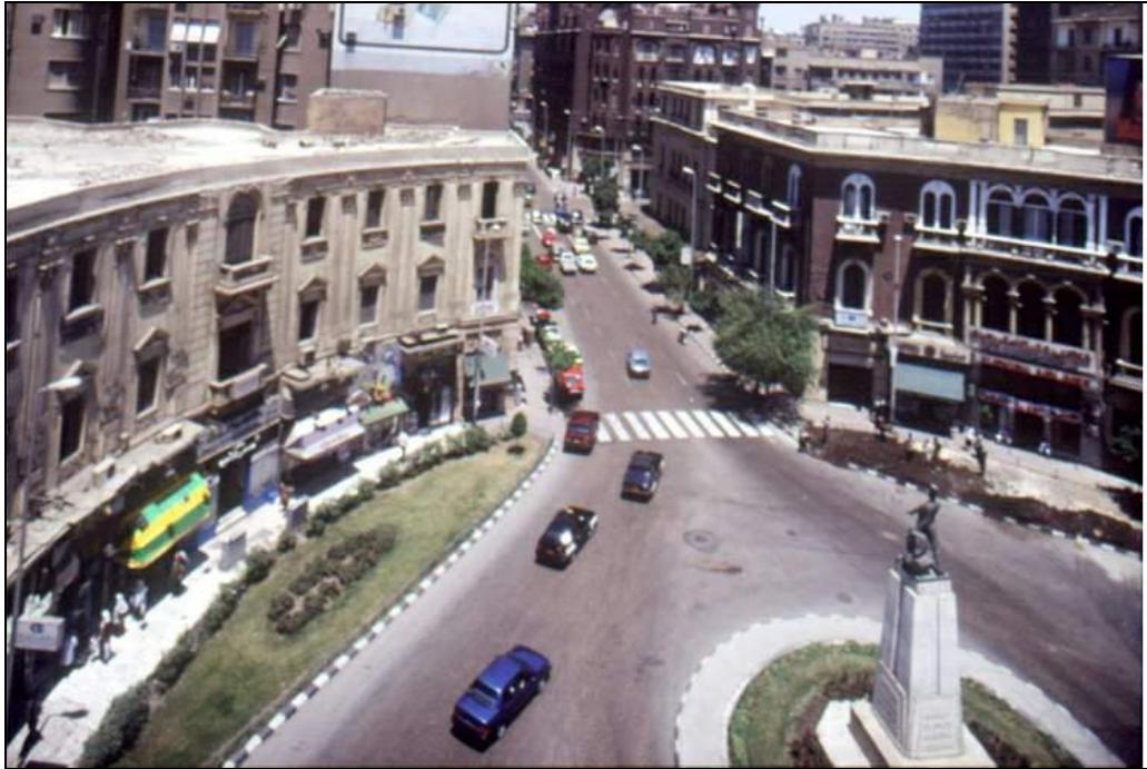
شكل ( ٣-٤ ) : ميدان " مصطفى كامل " بالقاهرة الحديثة (٢) ( المنطقة المركزية - القاهرة الحديثة )
