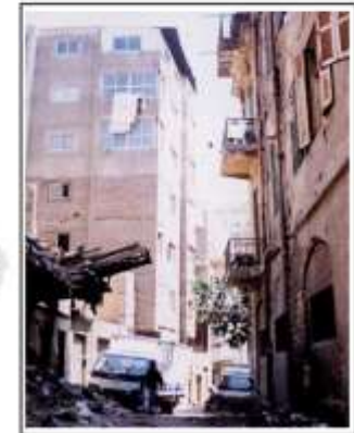
(٢) : حارة " الطواشي " من شارع " البيديق " وتظهر بها مباني متدهورة وعمارة حديثة
