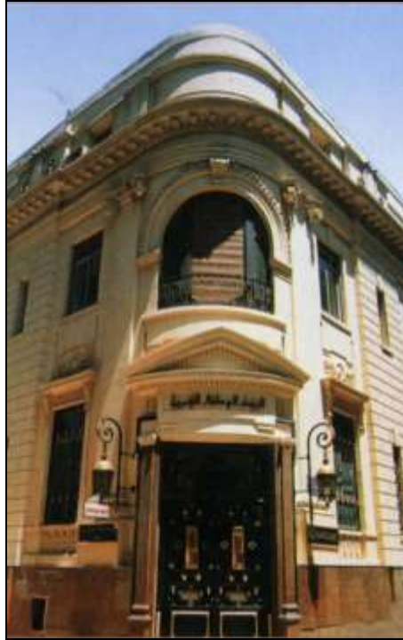
شكل ( ٤-١٨ ) : البنك الوطني للتنمية - شارع البورصة الجديدة عام الإنشاء فيما بين عامي ١٩٠٦ ، ١٩١٣م طراز نيو باروك (٢) أحد مباني الأنشطة المالية بمركز المدينة
