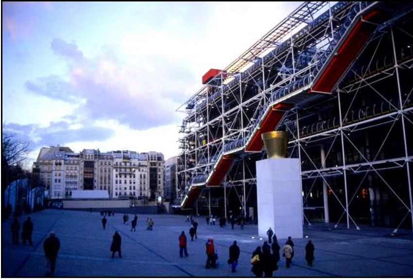
شكل (١٥-٢) : مركز بومبيدو Pompidou Centre وجزء من الساحة التي تقع أمامه بحي " لو ماريه " الذي أنشأ في موقع أرض الجذر غير الصحية التي أزيلت في الثلاثينات (١)
