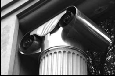
شكل رقم (14-1) تاج لأحد الأعمدة الأيونية والمصنوع من الصلب الذي لا يصدأ
