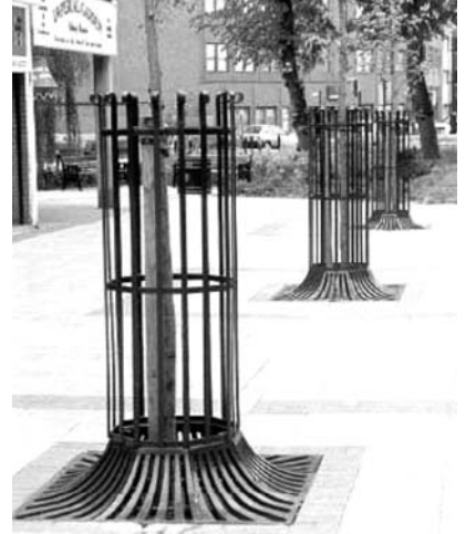
شكل(٢٣-٤) حماية الأشجار للخدمة الشاقة من قطاعات الحديد
