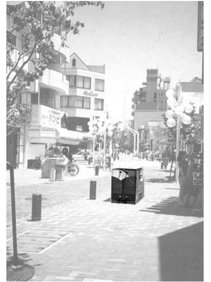
شكل(٤-٥٧) صناديق المحولات الكهربائية
