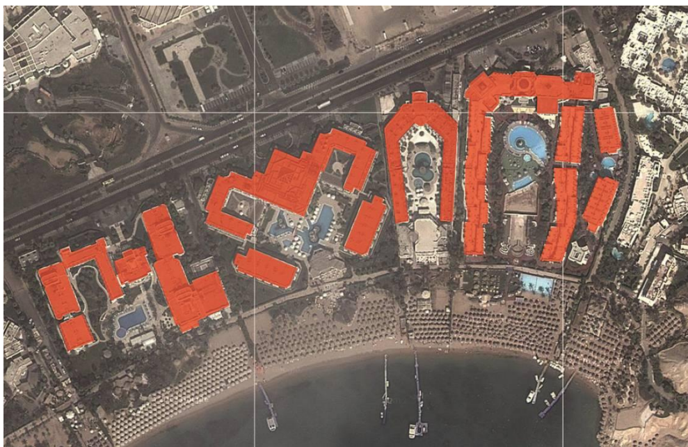
Figure 1.6 : Des bâtiments mitoyens formant des regroupements orientés vers la mer, « Mövenpick Hotel », « Gafy Resort » et « Al-Bostan Park », Charm El-Cheikh, Sinäi.
