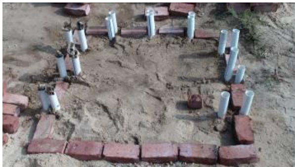
Combler le terrain et construire les fondations des murs
