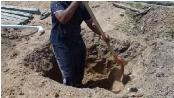
Creuser le terrain
