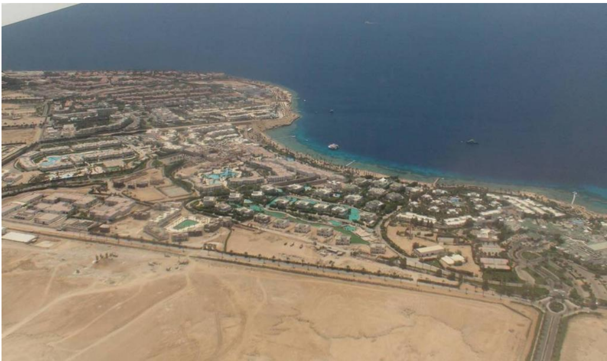
Figure 1.5 : Vue de l'avion sur la ville de Charm El-Cheikh montre la forme urbaine horizontale (deux étages maximum), Charm El-Cheikh, Sinäi.
