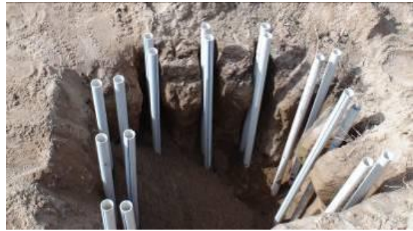
Mettre les tuyaux de ventilation indirecte
