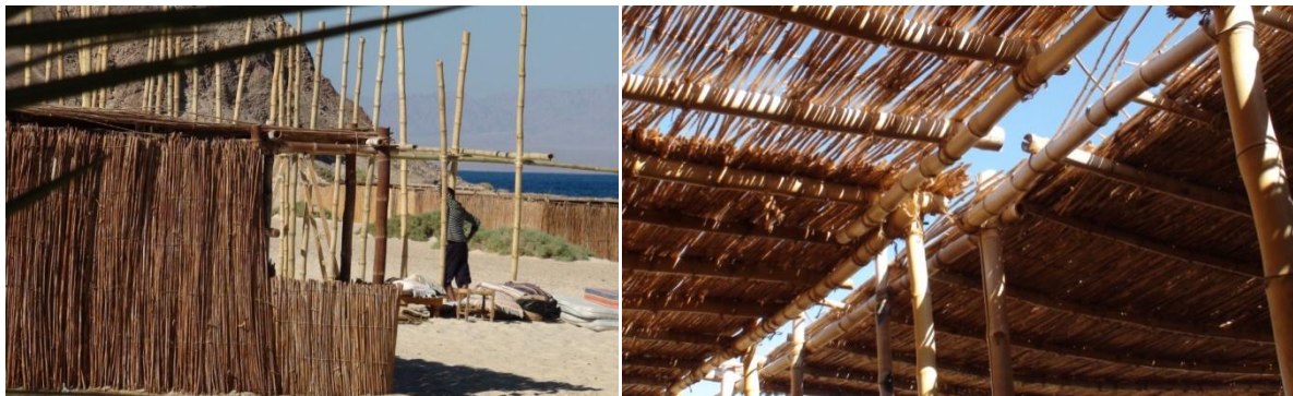
Figure 2.28: La construction en roseaux pendant l'exécution, le village touristique de « Basata », Taba route de Nuweiba, Sinai.
