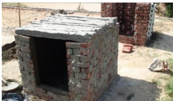
Construire la dalle en béton
