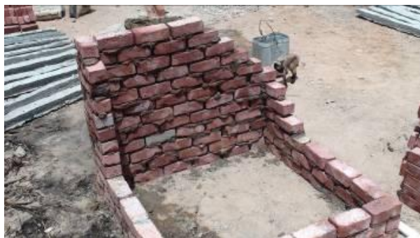
Construire les fondations des murs
