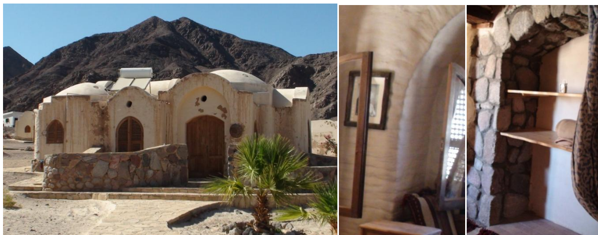
Figure 2.20 : La logique de la masse thermique qui a été utilisée en utilisant de la pierre de granit avec des briques en terre cuite dans les bâtiments du village touristique de « Basata », Taba route de Nuweiba, Sinai.
