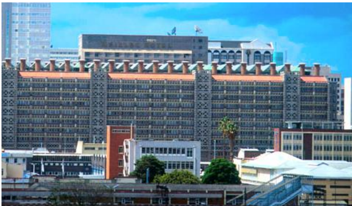
Figure 1.19 : Le bâtiment d'Eastgate à Zimbabwe [Turner et Soar, 2008, p.2].
