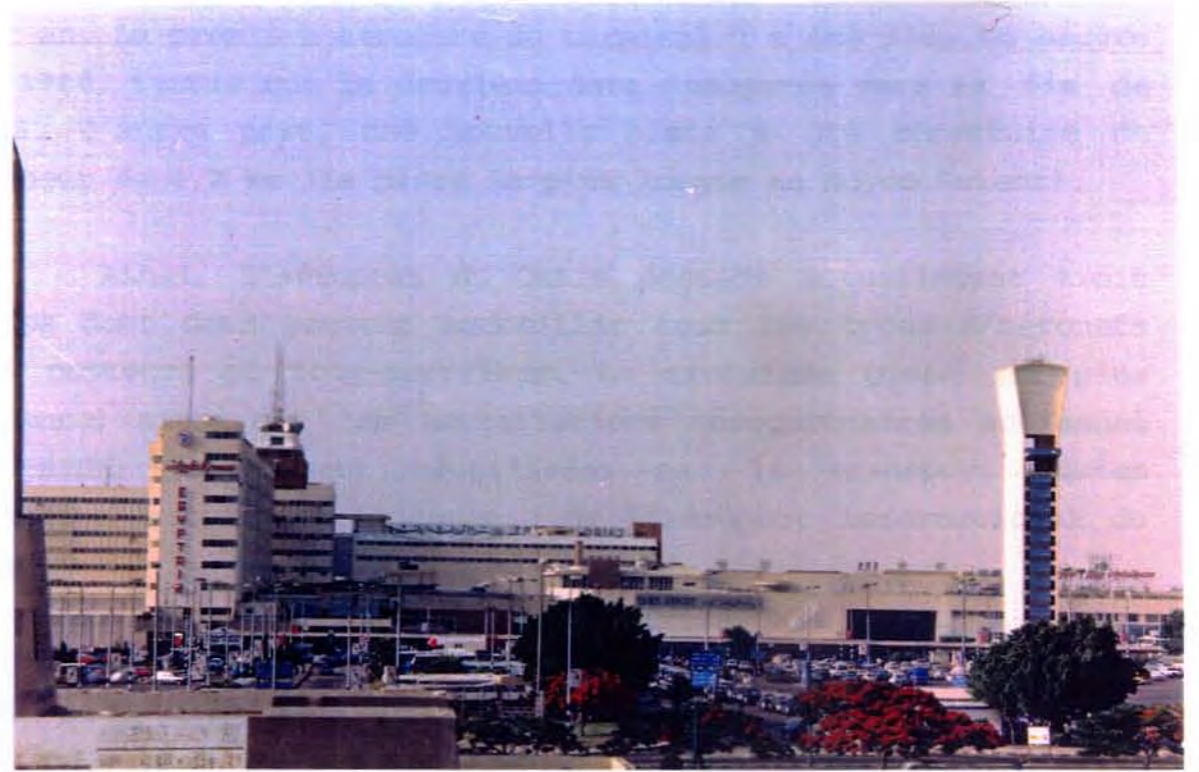
Fig. 15: Vue d'ensemble de la première aérogare -construite en 1963- du terminal 1 de l'aéroport du Caire
