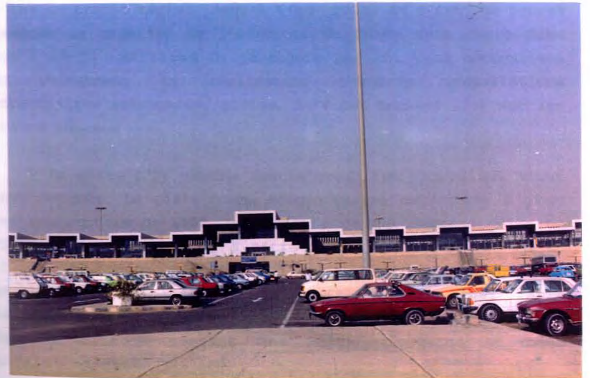
Fig. 16: Vue de façade de la première aérogare -construite en 1985- du terminal 2 de l'aéroport du Caire
