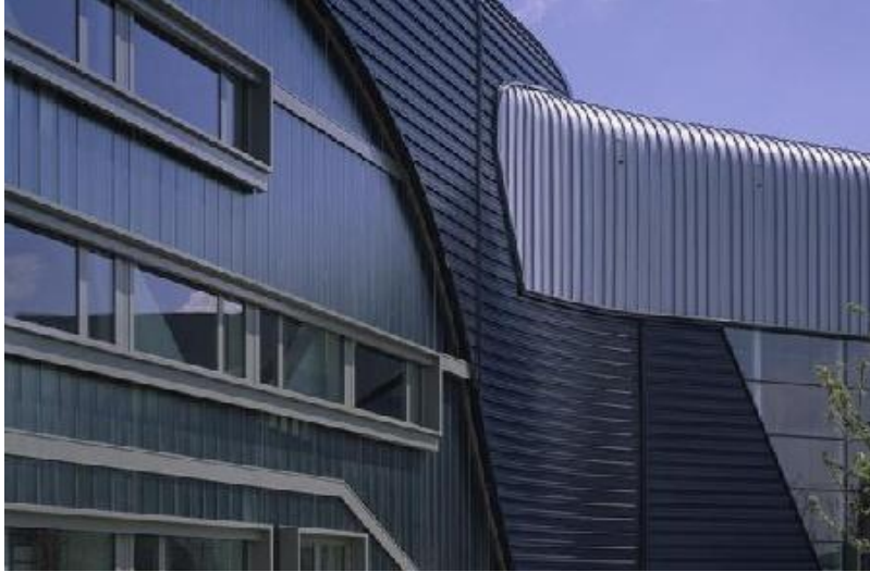
شكل رقم ١٧-٤ المبنى المركزي لشركة بي أم ديليو، بألمانيا، وقد استخدمت فيه المصممة زاها حديد كسوة الكالزيب (المصدر: تقرير المشروع، ٢٠٠١)
