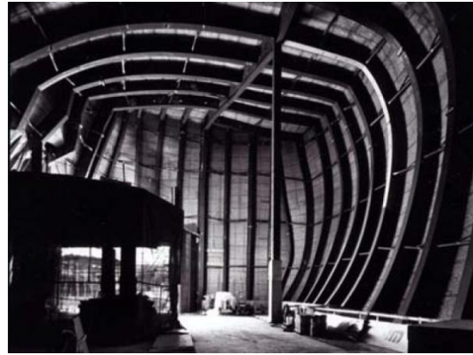
شكل رقم ٢٧-٣ الدعامات الداخلية منحنية وليس لها شكل منتظم
