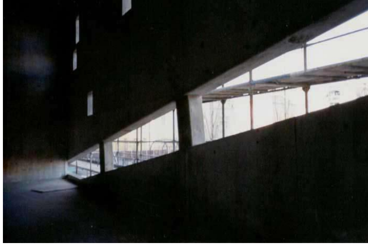
شكل رقم ٣-١٢ احدى مراحل بناء المتحف قبل التشطيب وتوضح الصورة البناء الخرساني، وتعدد الأبعاد المستخدمة للفتحات والشبابيك (المصدر: Emma E. Scarmack, 2004)
