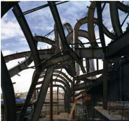
شكل رقم ٢٨-٣ الكمرات الحديدية التي تشكل هيكل المبنى
