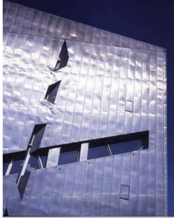
شكل رقم ٣-١٥ يوضح كسوة المبنى المصنوعة من الزنك ومقسمة إلى أجزاء صغيرة (المصدر: Emma E. Scarmack, 2004)
