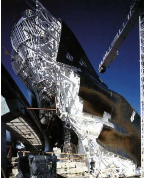
شكل رقم ٣-٣٠ الكسوة الخارجية أثناء عملية التركيب
