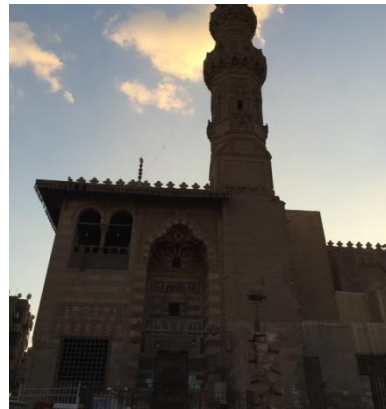
Fig. (170): Sultan Qaytbay Complex
