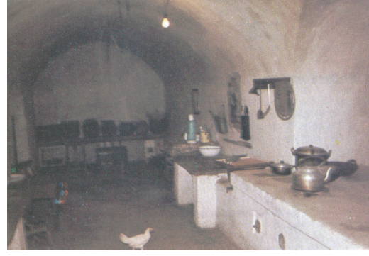
شكل (٧٨-١): صورة توضح فراغ المطبخ ذو السقف المقبب لتوزيع الأحمال ووحدات الأثاث المبنية. (عالم البناء، عدد ٦٥، ص ١٦).
