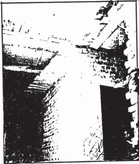
شكل (٣-٥) : استخدام الكرتون والنخيل في الاسقف .
