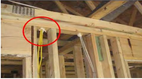
شكل (٢٥٨/٥): عزل الفواصل والوصلات الكهربائية
