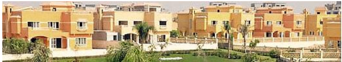
شكل (٤-٧٩) يوضح الإدراك البصري لبعض ملامح عناصر الواجهات الخارجية وما يربطها من فراغات بينية
