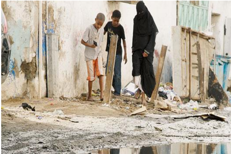
شكل ٣-١-٢ جانب من مخالفات منطقة الرويس يوضح فيه عشوائيات البناء وتدهور البنية التحتية والصرف الصحي للمنطقة.- المصدر - الباحث
